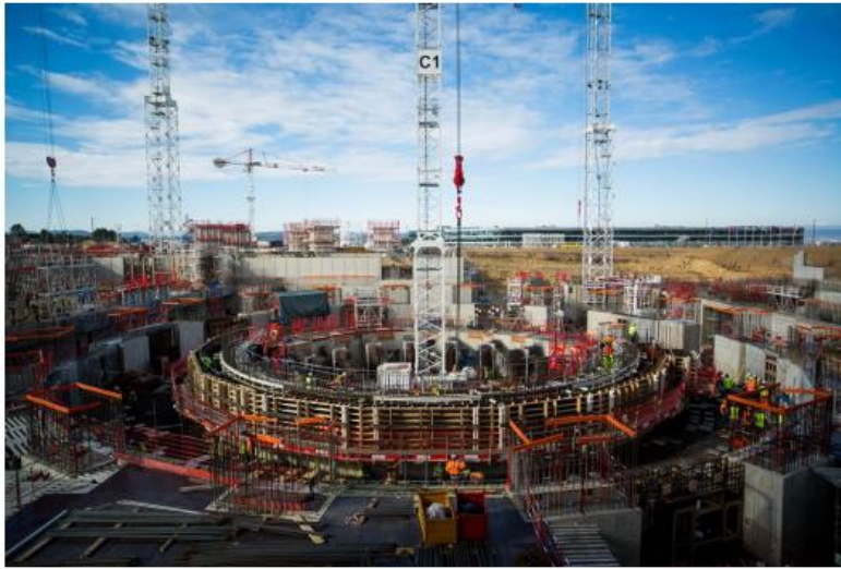
Şekil 2.14: Fransa'nın Cadarache kentindeki ITER şantiyesi (Chou vd., 2016).
