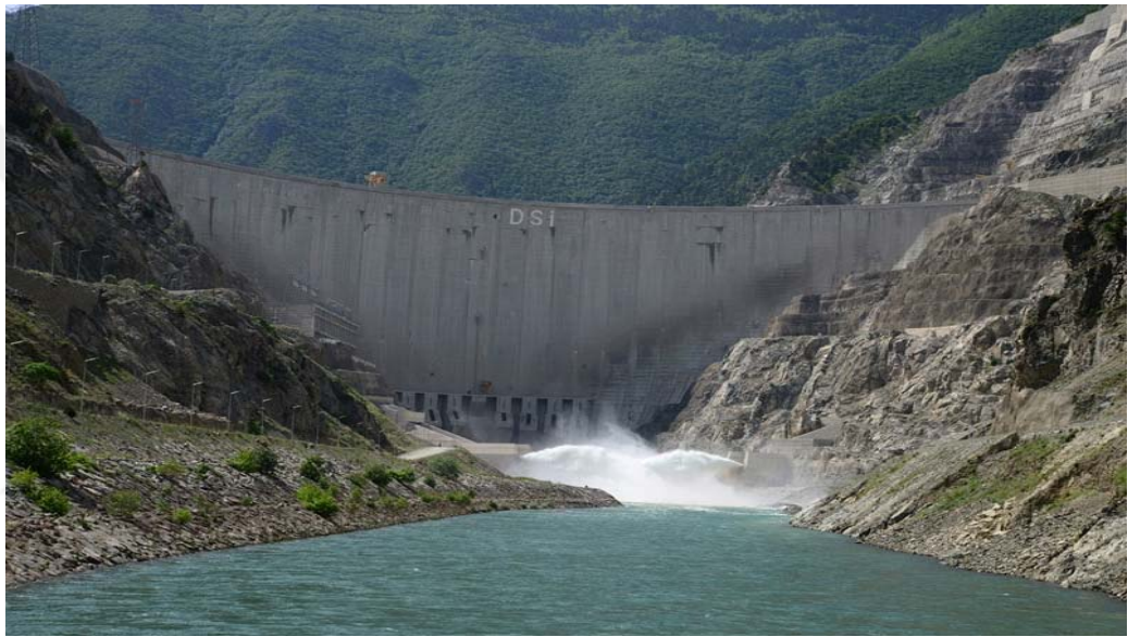
řekil 5. Deriner barajının görünümü (DSİ, 2014)
