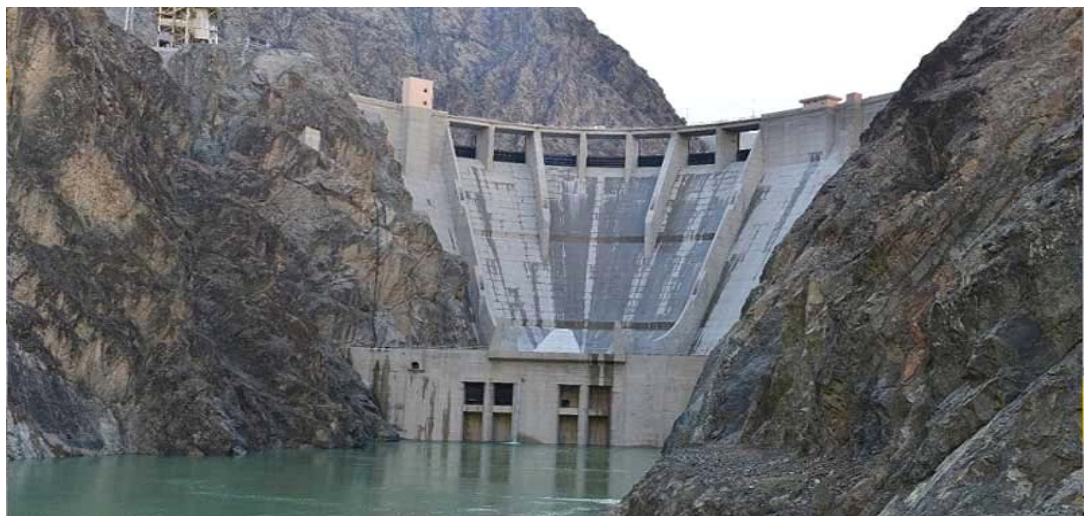
Şekil 8. Yusufeli barajı ve HES inşaatının ilerlemiş hali ( www.enerjiportali.com ).
