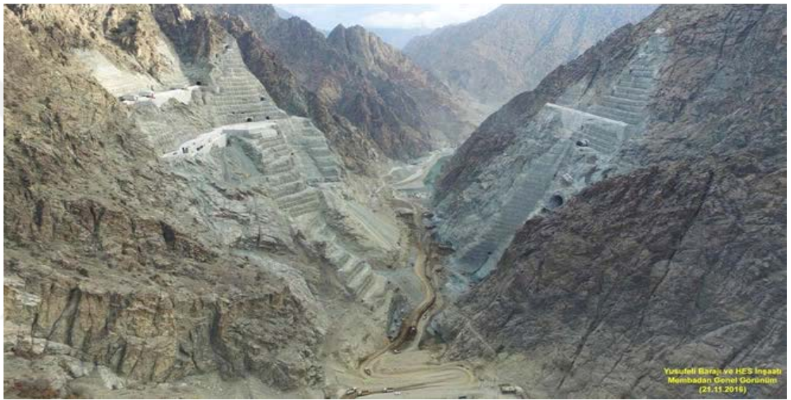
Şekil 7. Yusufeli barajı ve HES inşaatı 2016 ( www.enerjiatlasi.com ).
