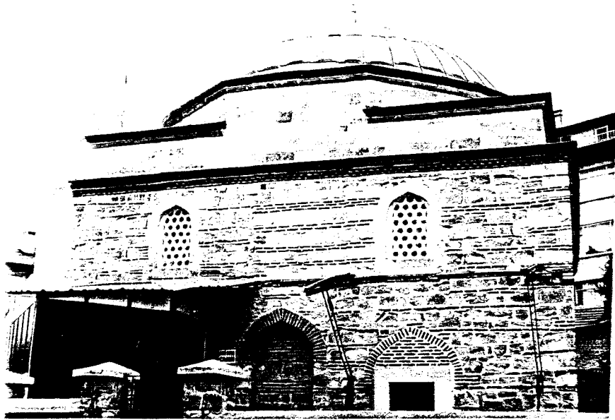
Resim 120- Gazi Hoca Camii. Kuzey cephesi.
