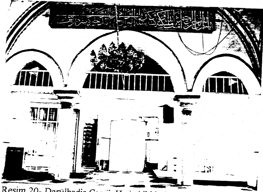
Resim 20- Darülhadis Camii. Harimi iki bölüme ayıran kemerlerin güney kesimi.
