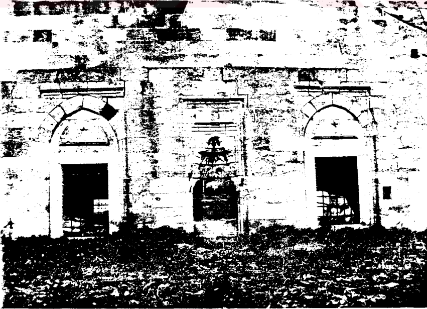
Resim 84- Kasım Paşa Camii. Kuzey cephesindeki pencereler ve dış mihrap.
