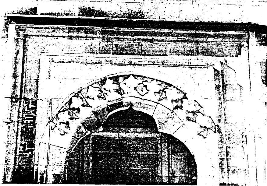
Resim 8- Şah Melek Camii. Doğu taçkapısının üst kesiminden ayrıntı.
