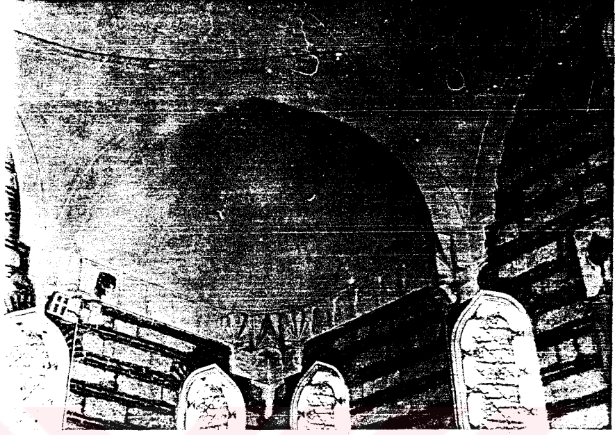
Resim 175- Deftardar Mustafa Paşa Camii. Harimin güneydoğu köşesindeki tromp.
