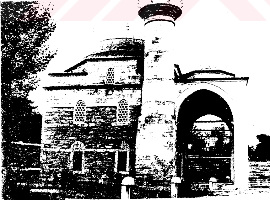
Resim 140- Hızır Ağa Camii. Doğu cephesi.
