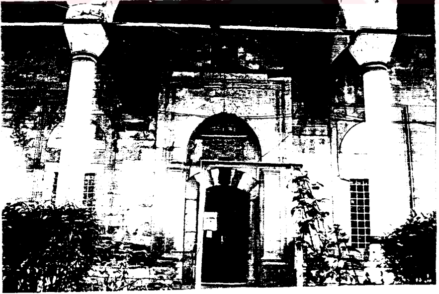
Resim 128- Lâri Camii. Harim taçkapısı.
