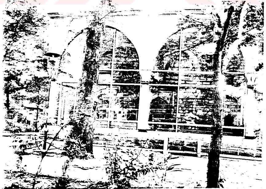
Resim 132- Kadı Bedreddin Camii. Son cemaat yerinin kuzeyden görünüşü.
