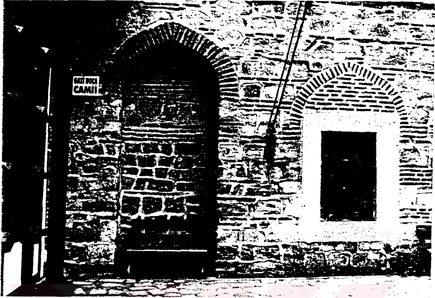
Resim 121- Gazi Hoca Camii. Kuzey cephesi üzerinde yer alan dış mihrap.
