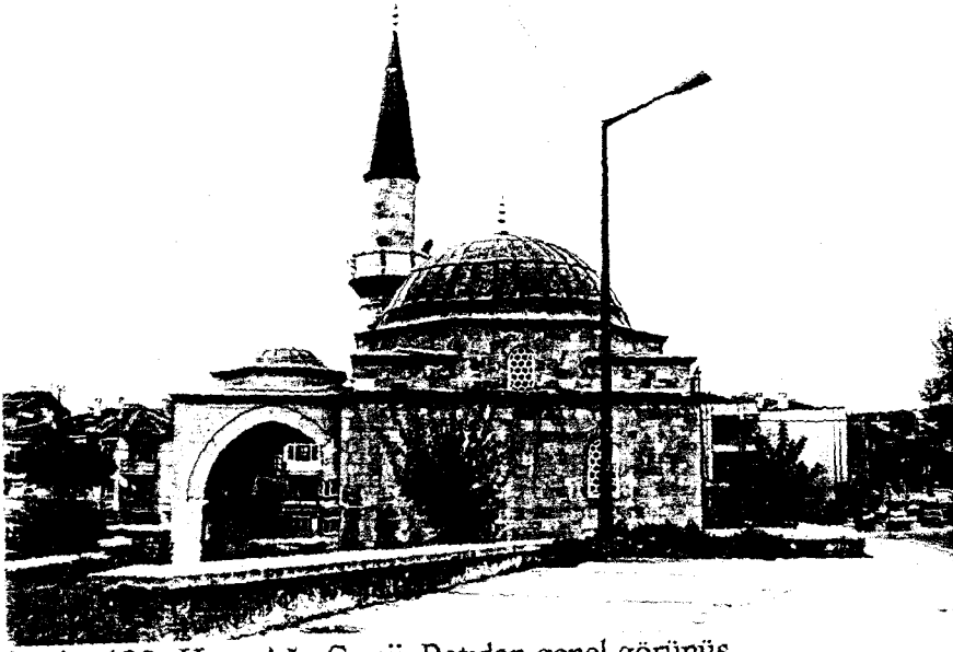
Resim 139- Hızır Ağa Camii. Batıdan genel görünüş.
