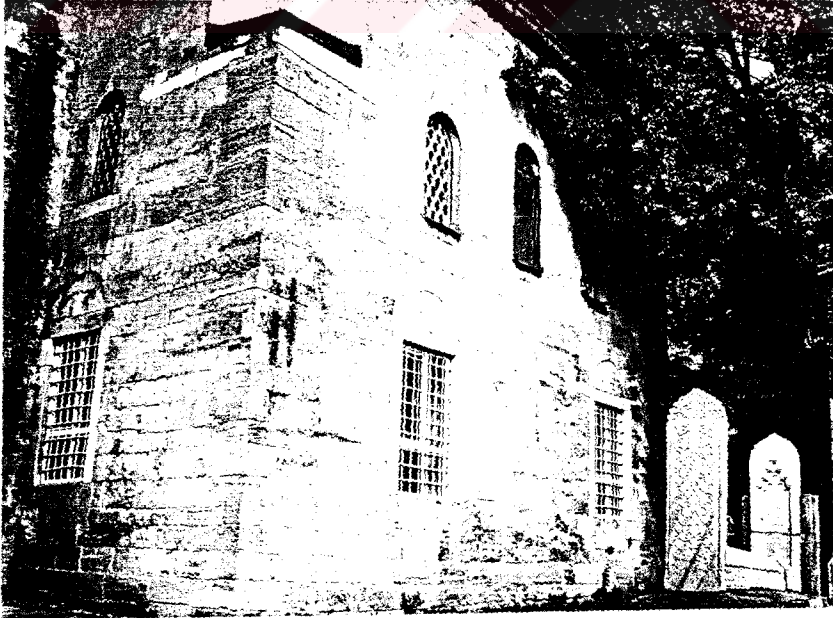
Resim 18- Darülhadis Camii. Batı cephesinden alınmış bir ayrıntı.
