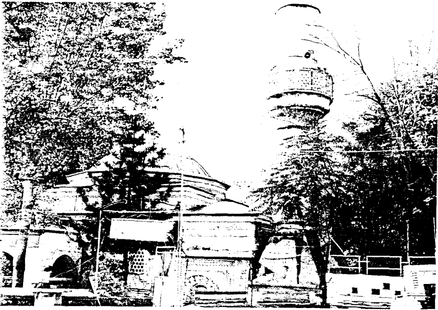
Resim 6- Şah Melek Camii. Doğu cephesinden genel görüntü.
