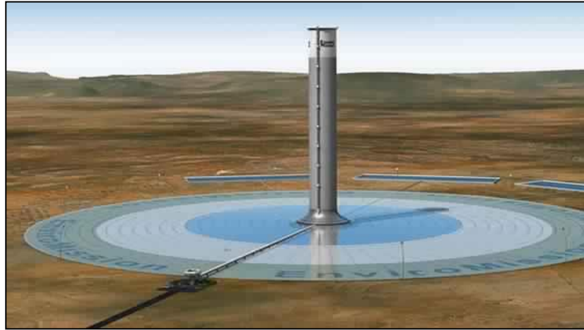
Şekil 4.4 Güneş bacası ile elektrik üretimi
