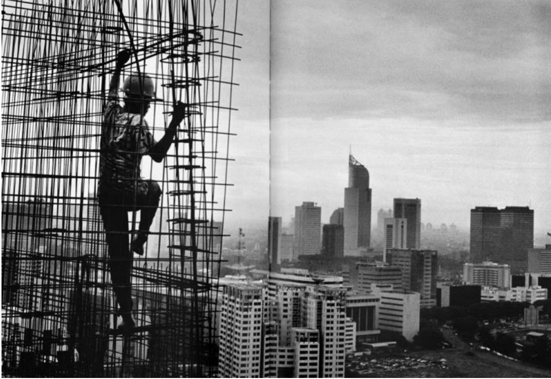
Fotoğraf 55 - 18 kule, 4300 apartman dairesinin yanı sıra ofis ve işyerlerini de bünyesinde bulunduracak olan Rasuna binasının inşaatı, Jakarta, Endonezya, 1996 © Sebastião Salgado
