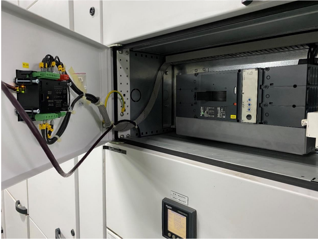
Şekil 4.12. MPR-47SE enerji analizörünün bağlantı şeması
