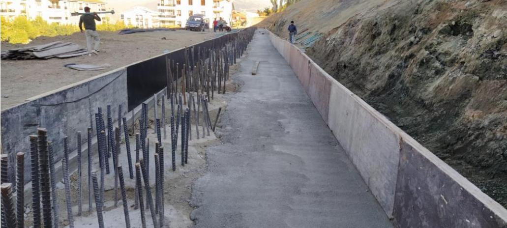
Şekil 4. 17 Şevin Topuğunda Yapılmış Kazıklar ve İstinat Duvarının Ampatman Kalıpları
