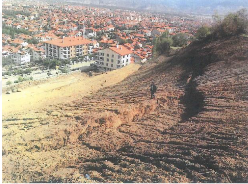
Şekil 3. 3 Aralık 2014'te Arazide Oluşan Heyelan (Kuzeydoğu Yönü) (Gürdal, 2014)
