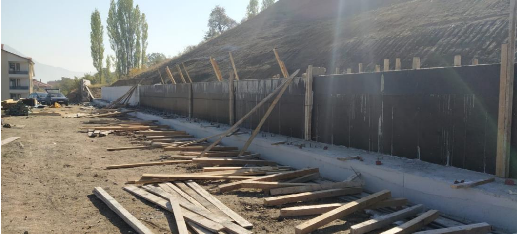
Şekil 4. 18 Şevin Topuğuna Yapılan İstinat Duvarı
