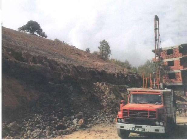
Şekil 3. 4 Şevin Topuk Bölgesinde Gerçekleştirilen SPT Deneyi (Gürdal, 2014)
