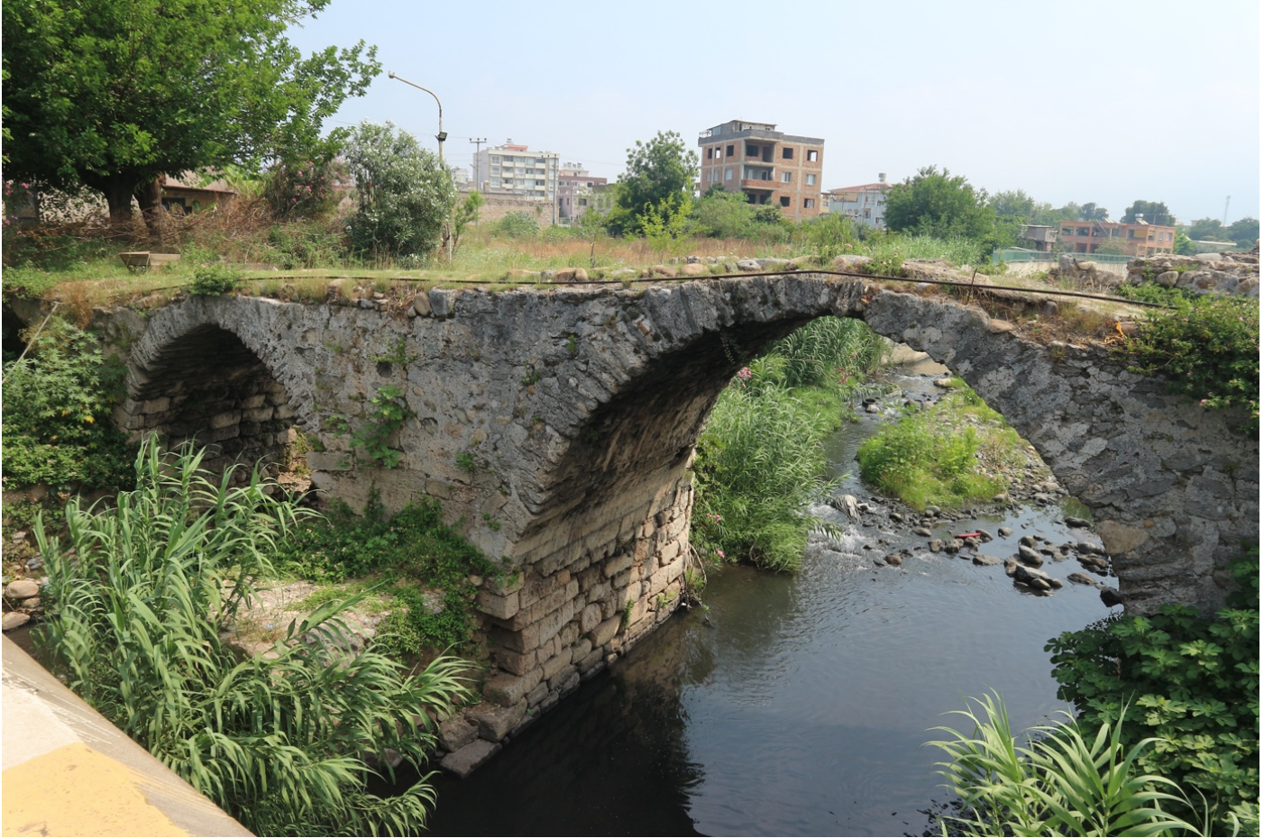
Şekil 77: Payas Sokullu Mehmet Paşa Köprüsü (Selahattin Öksüz Arşivinden)
