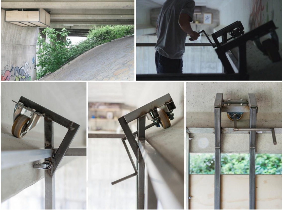
Şekil 4.133. Hidden Studio'nun hareket sistemine ait görseller (Dezeen, 2017b)
