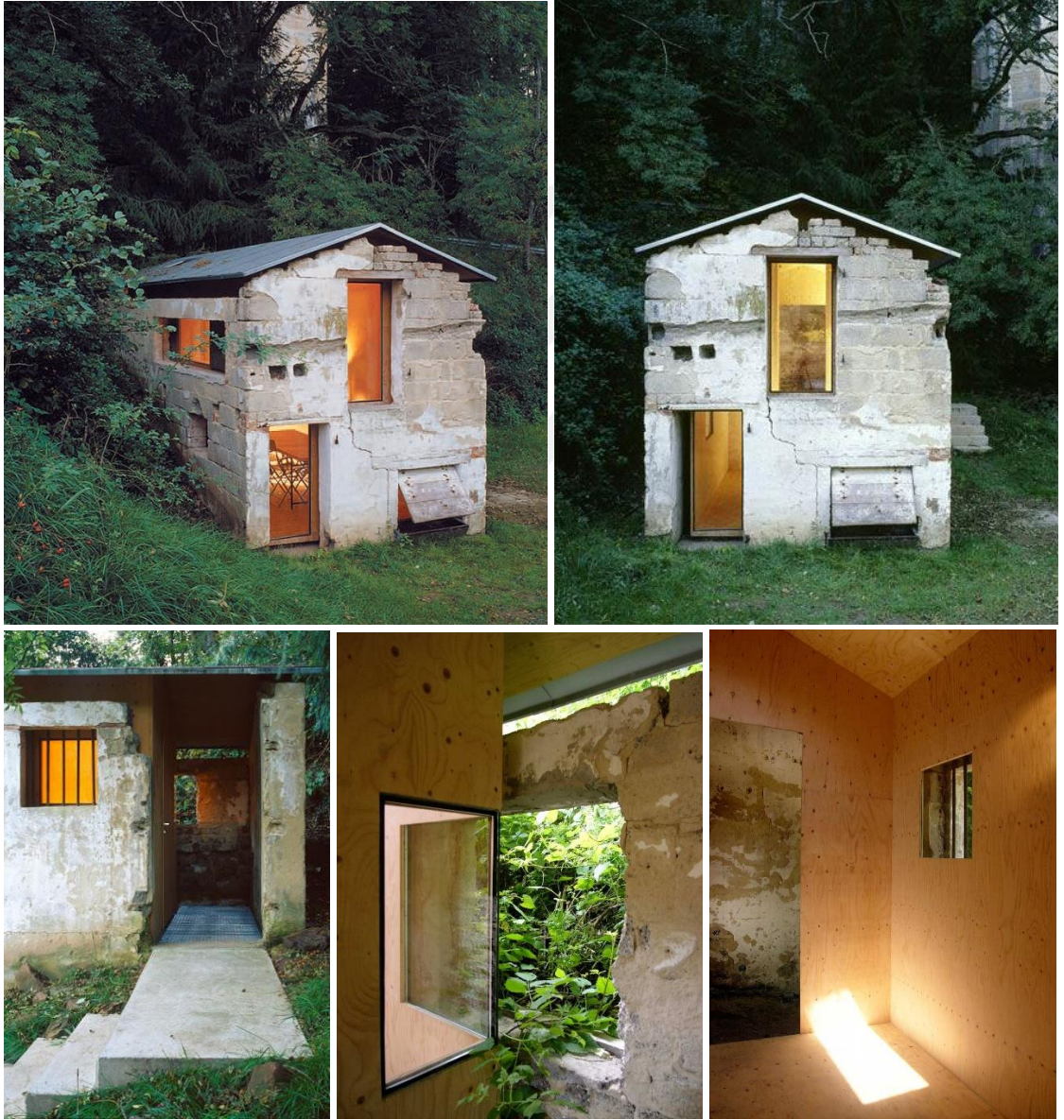
Şekil 4.125. S(ch)austall'a ait dış ve iç mekân fotoğrafları (Arqa, 2011)
