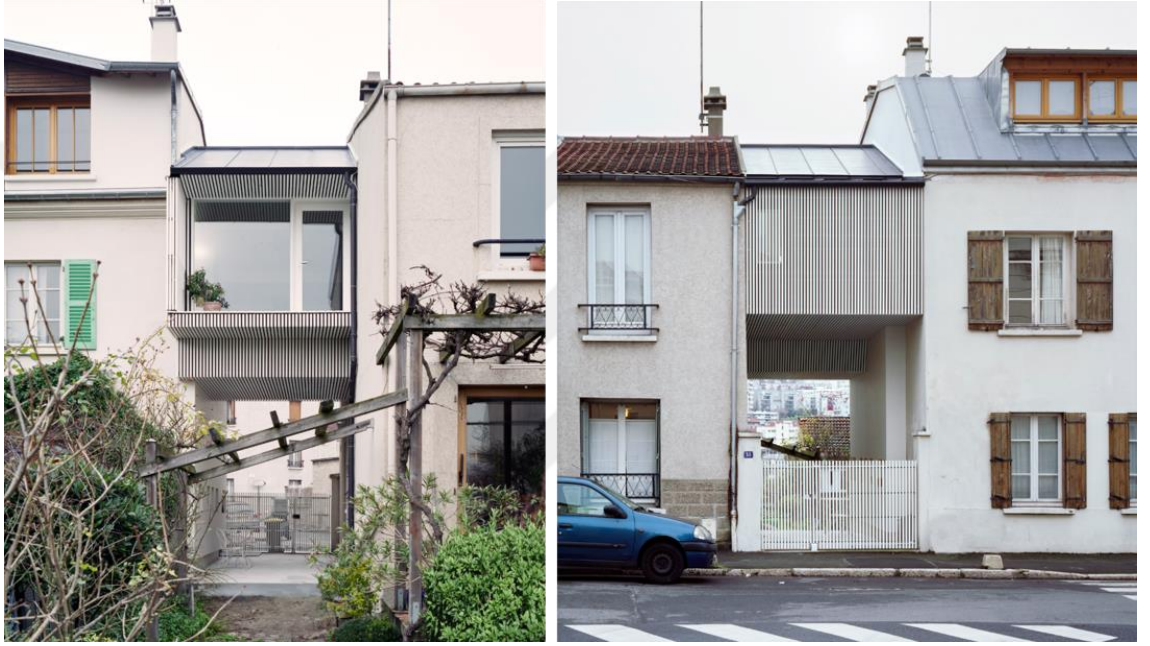
Şekil 4.154. Chambre Suspendue'ye ait ön (giriş) ve arka cephe fotoğrafları (Darchitectures, 2014)
