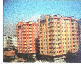
b-Konut Cephe Uygulaması - Konya
