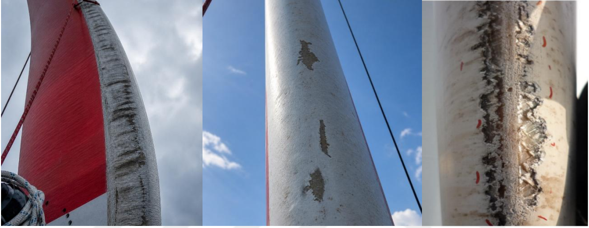
Şekil 4.2.6.1. Ön kenar erozyon hasarları
