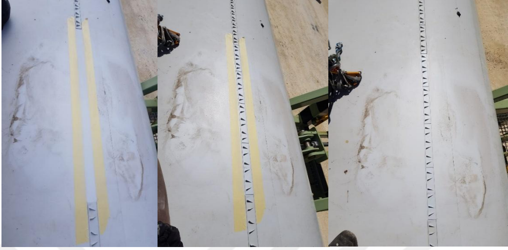
Şekil 4.6.2.1. Vortex onarım adımları
