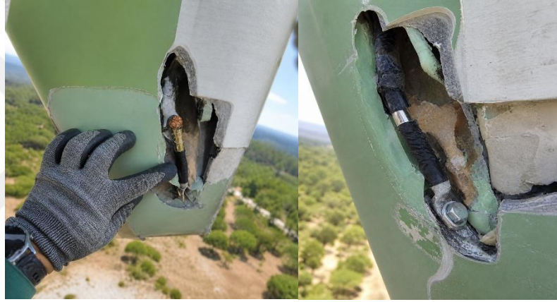
Şekil 4.5.11.2. Onarılan LPS kablosunun bağlantısı
