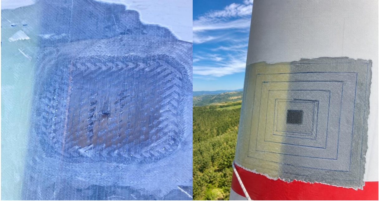
Şekil 4.3.12.2. Yüzey taşlama ve kat açma işlemi
