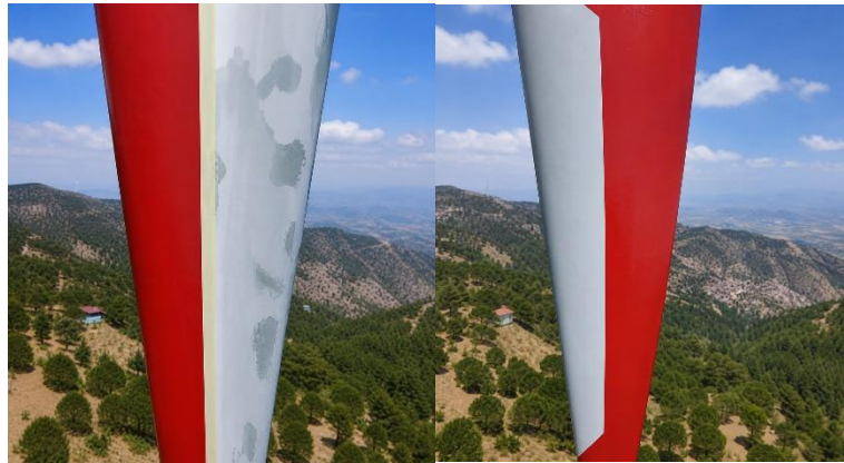
Şekil 4.5.11.3. Macun uygulaması ve boya işlemi
