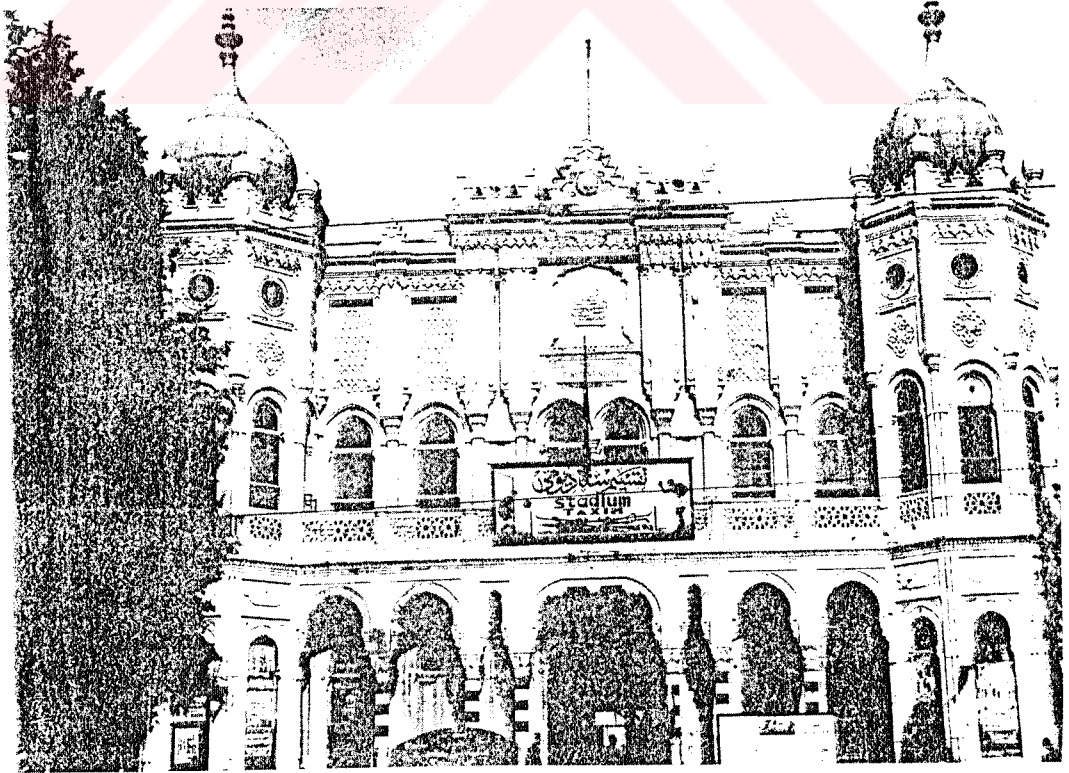
Şekil 2.14 Topçu Kışlası'nın 1920'lerdeki görünümü.
