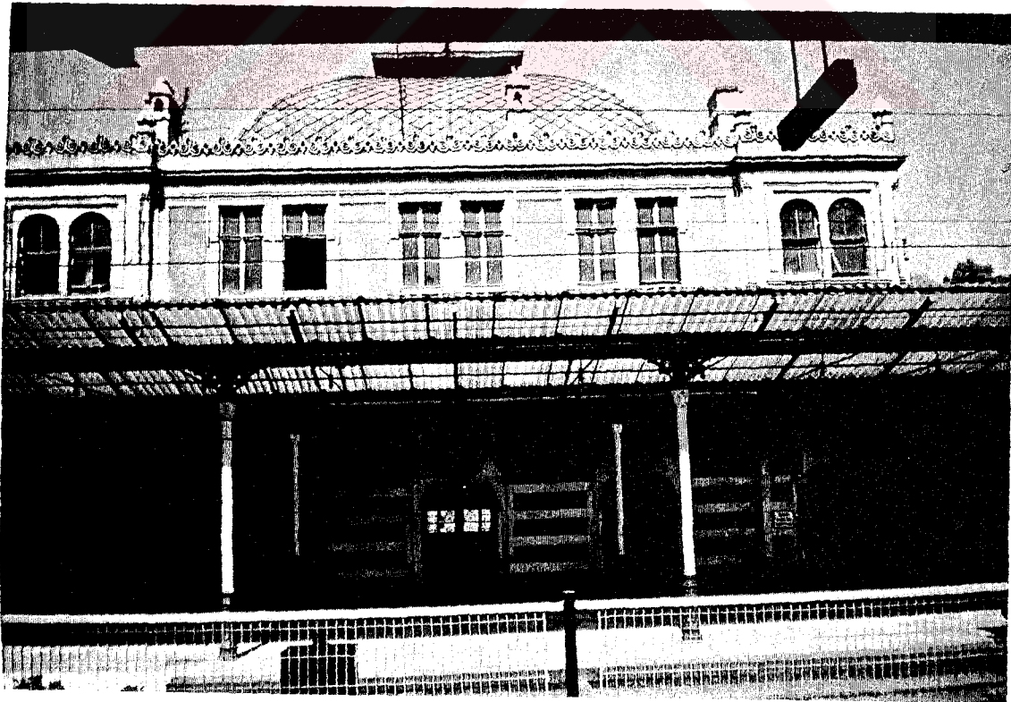
Şekil 7.6 Sirkeci Garı, İstanbul, arka cephe
