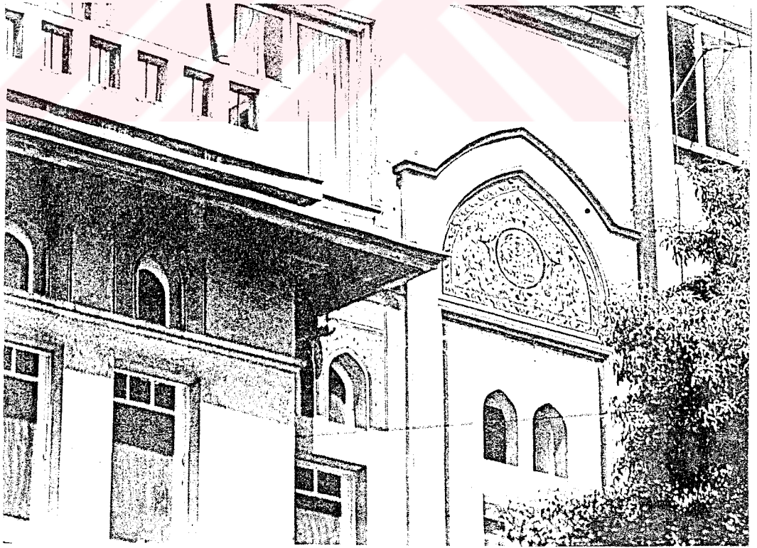
Ek A.6 Mimar Vedat Tek Evi, cephesinden detay görünüm
