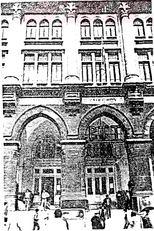
Ek A.3 Sirkeci Büyük Postane, cephesinden detay görünüm
