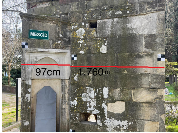
Şekil 4.4. ÇŞM kullanılarak gerçekleştirilen kontrol mesafe ölçmelerine örnek
