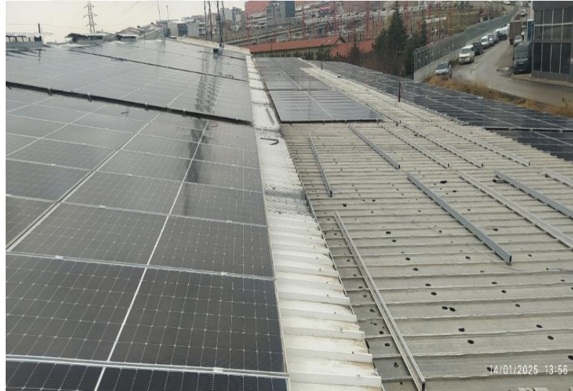
Şekil 4.8 Elektrik atölyesinin çatı görüntüsü
