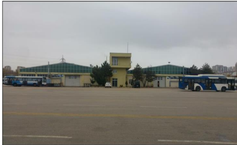
Şekil 4.2 Merkez atölye ana bina yandan görünüş
