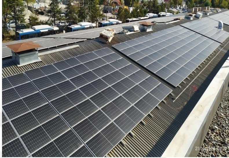
Şekil 4.7 Bakım atölyesi güneş panellerinin montajı
