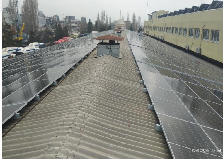
Şekil 4.6 Bakım atölyesi güneş panellerinin montajı
