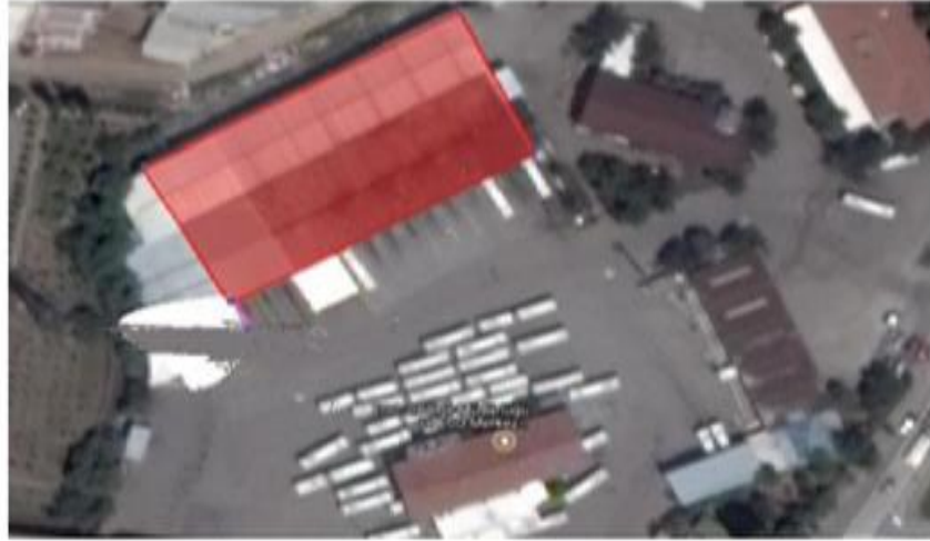
Şekil 4.4 Elektrik atölye binası üstten görünüş (Açıkgöz 2019)
