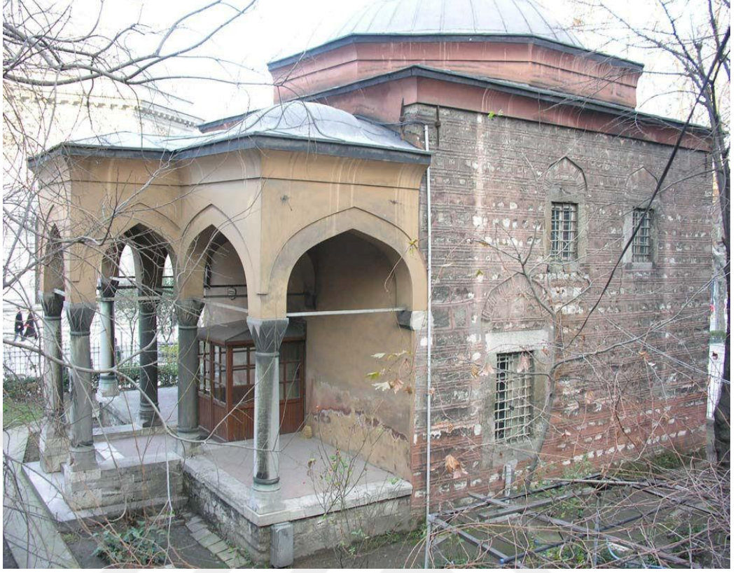
Fot. 7. Köprülü Kütüphânesi Dıştan Görünüm 369
