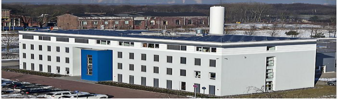
Şekil 2.10. Almanya Herten kentinde bulunan Hidrojen Depolama Tank Dairesi (Tietze vd. 2021)
