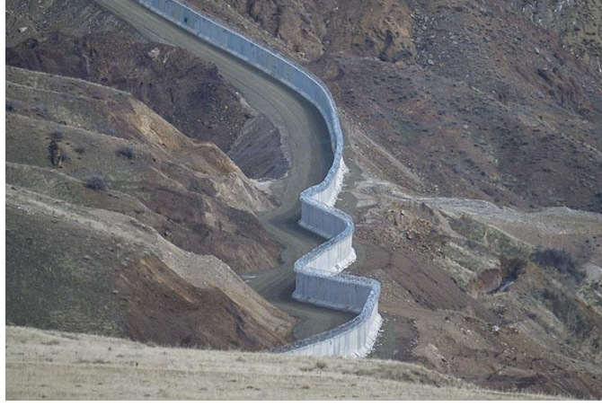
Görsel 14. Van Sınır Duvarı
