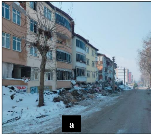
Şekil 1.3 : Kahramanmaraş'ta hasar gören binalar a) Zeyif kay ve b) yumuşak kat (AFAD, 2023).
