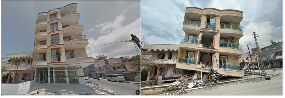
Şekil 1.7 : Deprem öncesi ve sonrası zayıf kat hasarı, İskenderun/Hatay(Yuzbasi, 2024)
