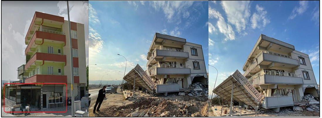
Şekil 1.8 : Zayıf kat nedeniyle yıkılmış bina, 06.02.2023 Pazarlık depremi (Yuzbasi, 2024).
