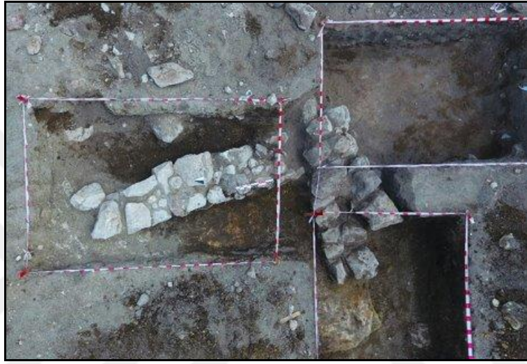
Fotoğraf 4.1. Hanefi Çeşmesi-2 Mimari Yapı Detayı 226 .
