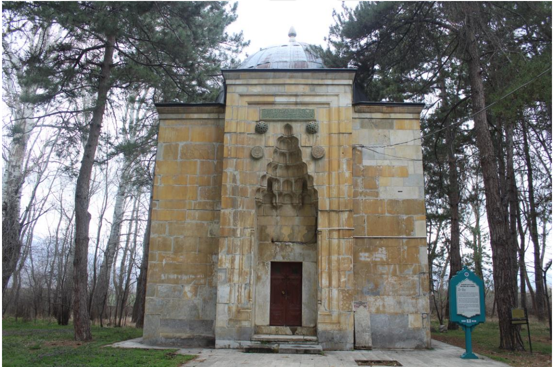
Resim 194: Şeyh Hacı İbrahim-i Veli Türbesi
