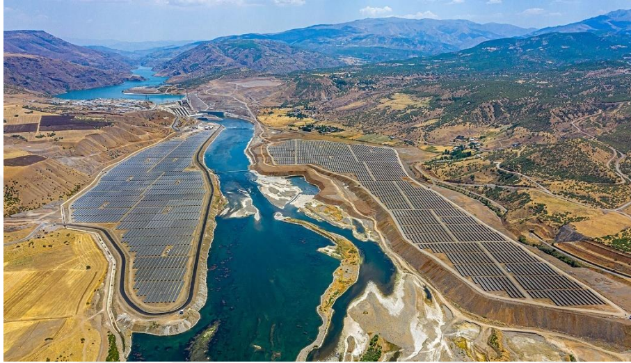
Şekil 4.1. Aşağı Kaleköy Yardımcı Kaynak Güneş Enerji Santrali
