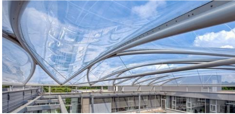
Görsel 31. ETFE Yapı Kabuğu, 2025
