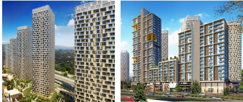
Görsel 53. Merkez Ankara Konutlar Dış Görünüm, 2025
