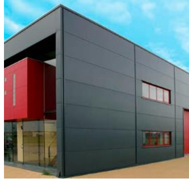
Görsel 24. Alüminyum dış cephe kaplama, 2025
