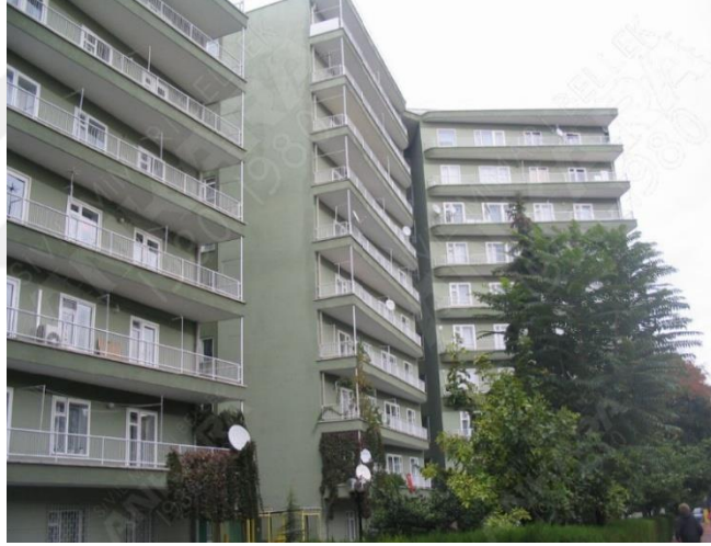
Görsel 49. Yeşiltepe Blokları Dış Cephe Görünümü, 2025
