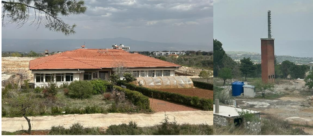
Şekil 5.55-56: Göveçlik İplik Fabrikası Yönetim binası v kazan dairesi bacası. (Yazar arşivi 2025)
