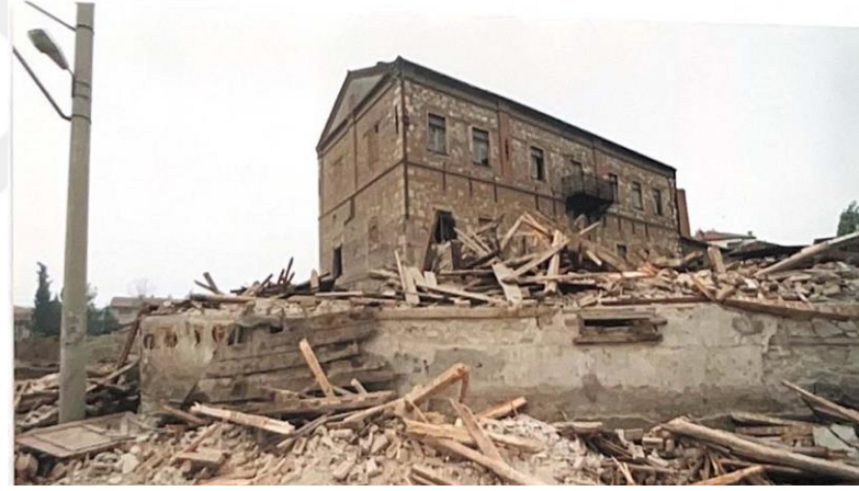
Şekil 5.15: Kùlahçioğlu Un Fabrikası İdari Binası Ek Yönetim Binası Yıkıldıktan Sonra (Denizli İl Kùltür ve Turizm Müdürlüğü Arşivi)
