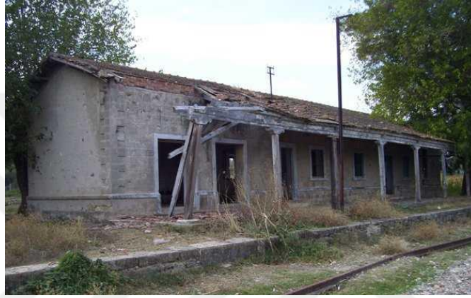
Şekil 5.92: Üzerlik İstasyonu Bekleme/İdare Binası ( https://kulturportali.gov.tr/turkiye/denizli/kulturenvanteri/tcddy-uzerlik-stasyonu-tesis-yapilari )
