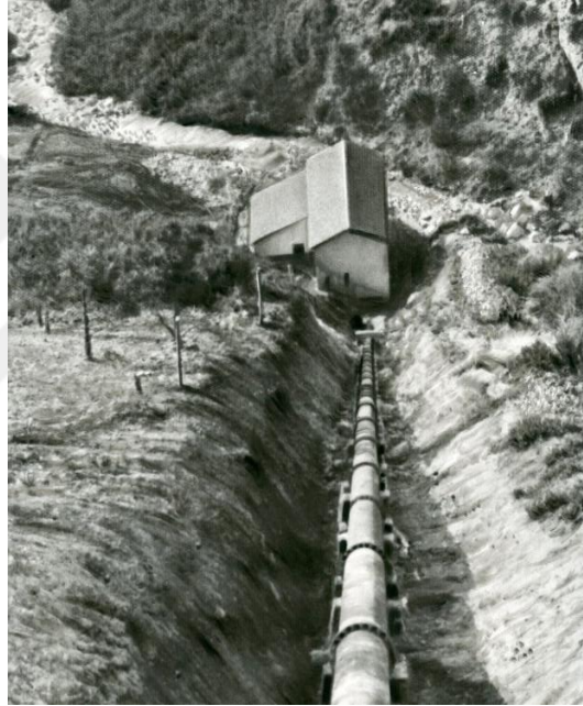
Şekil 5.124: Gökpınar I Hidroelektrik Santrali (Denizli Büyükşehir Belediyesi Arşivi)
