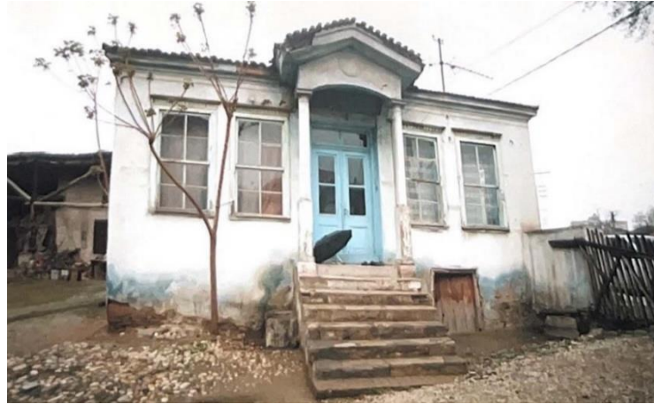
Şekil 5.16: Kùlahçioğlu Un Fabrikası İdari Binası (Denizli İl Kùltür ve Turizm Müdürlüğü Arşivi)
