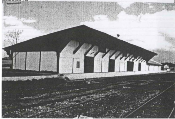
Şekil 5.97: Deniz Gar hangar yapısı (TCDD 3. Bölge Müdürlüğü Arşivi)
