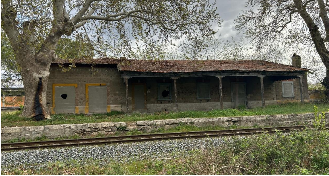
Şekil 5.104: Böceli (Bucalı) İstasyon yapısı (Yazar arşivi Mart 2025)
