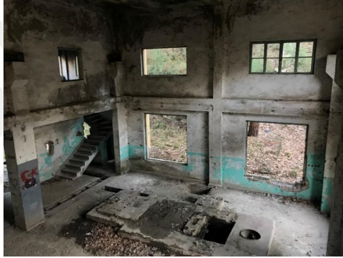
Şekil 5.131: Gökpınar II Hidroelektrik Santrali İçi (Yazar Arşivi 2022)
