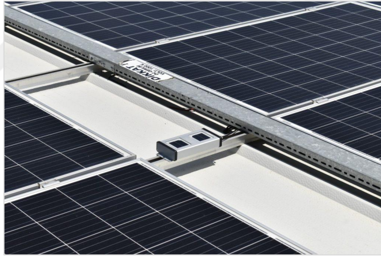
Şekil 35. Diziler arasına paralel yerleştirilen kirlenme sensörü (Seven, 2022)
