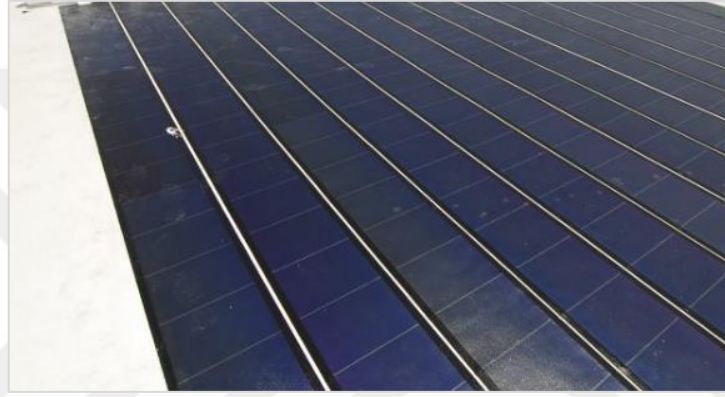
Şekil 22. İnce film çatı ges örneğı (Gezegen Solar, 2024)
