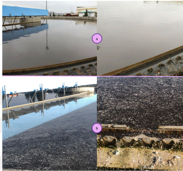
Şekil 46. Son çöktürme havuz yüzeyi: a) Aralık 2022, b) Ocak 2023
