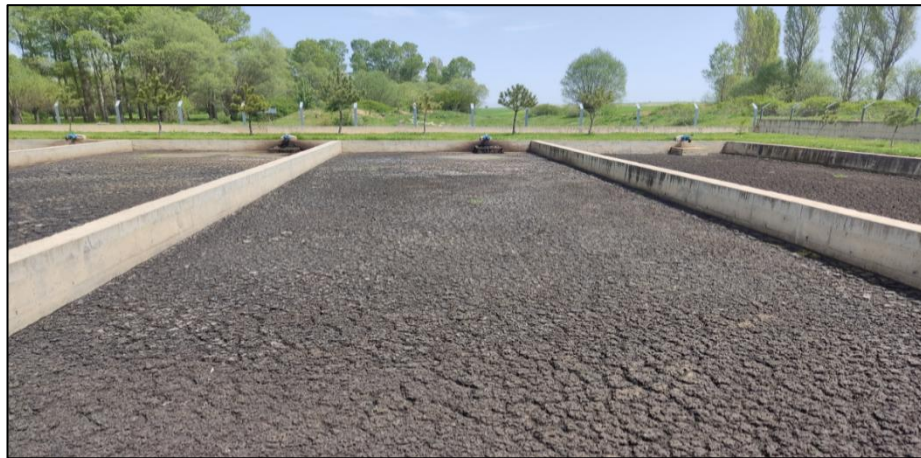
Şekil 3.2. Düzağaç atıksu arıtma tesisi çamur kurutma ünitesi
