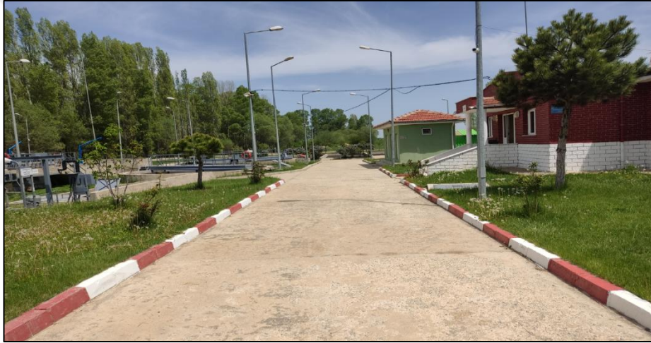
Şekil 3.1. Düzağaç atıksu arıtma tesisi
