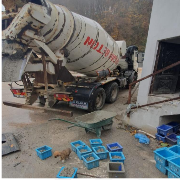
Şekil 3.7. Transmikserden beton alınması
