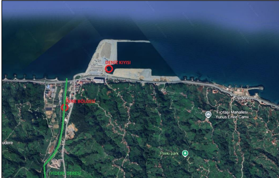
Şekil 10. Beton dökümleri uydu görüntülü lokasyonları
