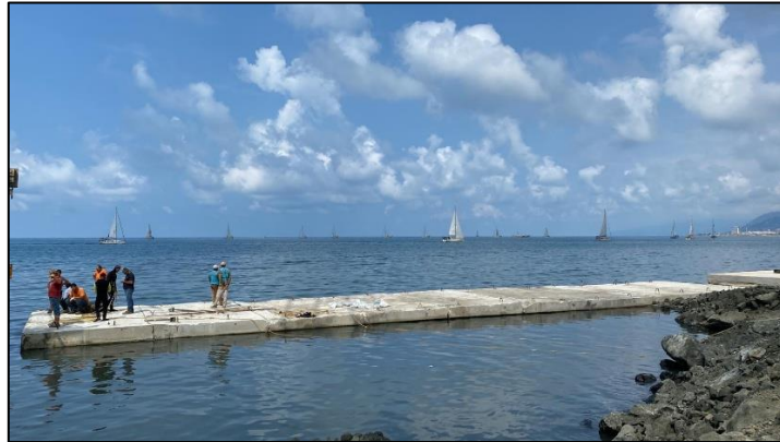
Şekil 5. Rize deniz kenarı su altı betonuyla inşa edilmiş kenar yapısı
