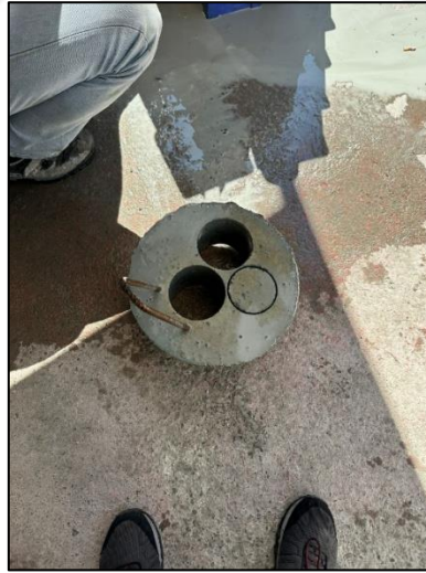
Şekil 8. Karot numune alınmış su altı betonu
