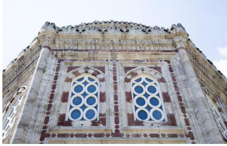
Şekil 2. 4. Şehzade Mehmet Türbesi Alçılı Revzen Örneği [12]
