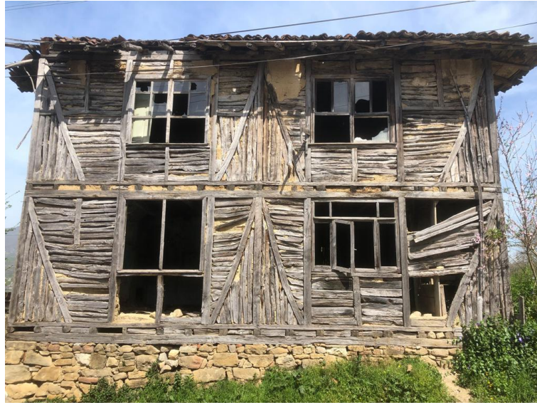
Görsel 1. Yıldız Evi Güney Cephesi
