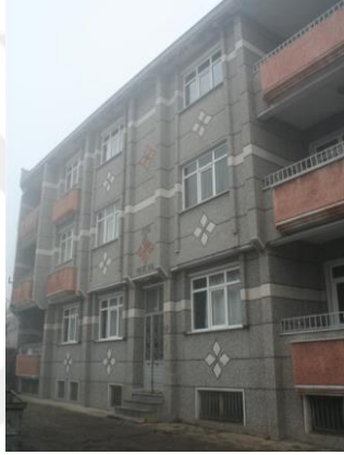
Şekil 5.6.b. Ön Cephe (2000 öncesi)
