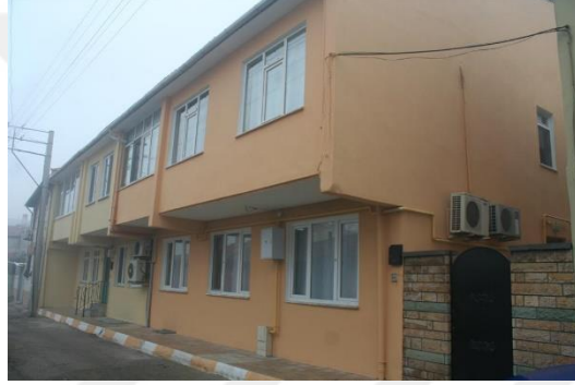
Şekil 5.1.b. Ön Cephe (2000 öncesi)
