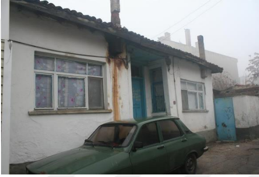
Şekil 5.10.b. Ön Cephe (2000 öncesi)
