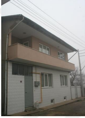
Şekil 5.13.b. Ön Cephe (2000 öncesi)
