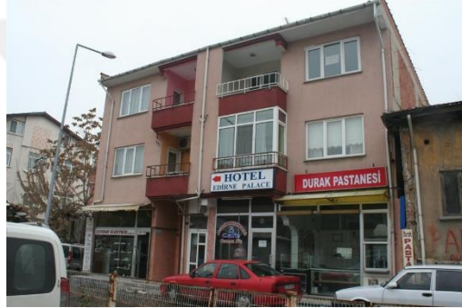
Şekil 5.9.b. Ön Cephe (2000 öncesi)
