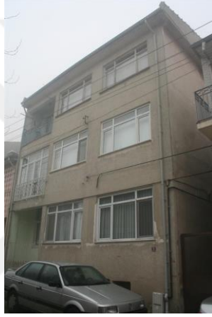
Şekil 5.11.b. Ön Cephe (2000 öncesi)
