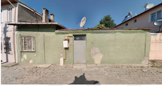
Şekil 5.3.b. Ön Cephe (2000 öncesi)
