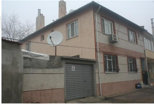
Şekil 5.2.b. Ön Cephe (2000 öncesi)
