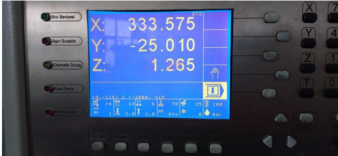
Resim 3.6. Tezgah kontrol paneli
