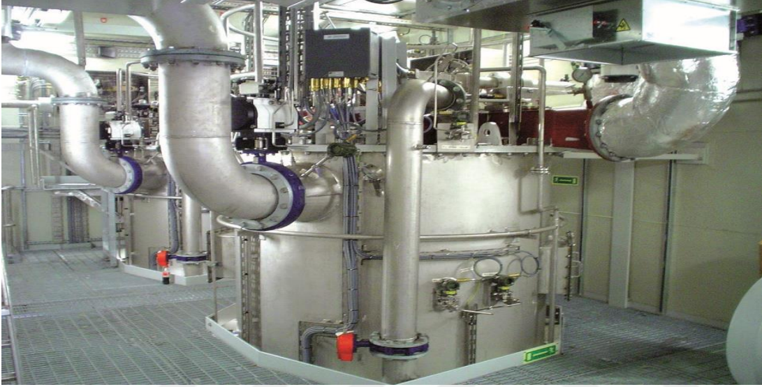
Şekil 5.8 : İnert gaz jeneratörü (URL-13).
