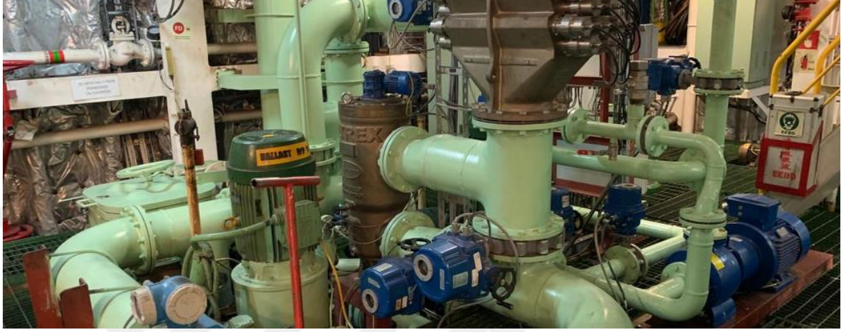
Şekil 5.17 : Balast arıtma ekipmanları (URL-23).
