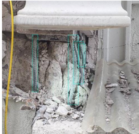
Şekil 3.4 : Farklı derinlik dolayısı ile sınırlayıcı kutuların iç içe geçmesi.
