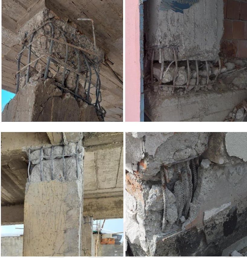
Şekil 3.1 : Kullanılan bazı boyuna donatı burkulma hasarı görüntüleri.
