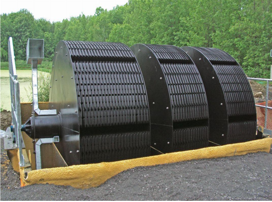
Şekil 3.21. Dönen disk biyofiltre (Climate Policy Watcher, 2023).
