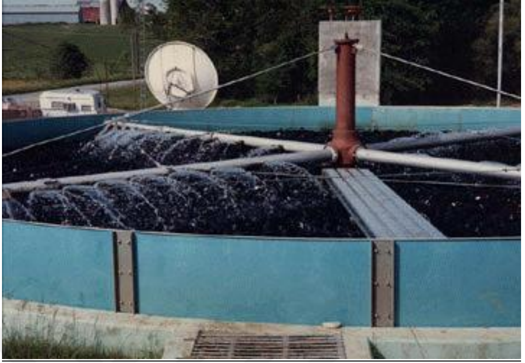
Şekil 3.19. Damlatma biyofiltre (DEÜ, 2024).
