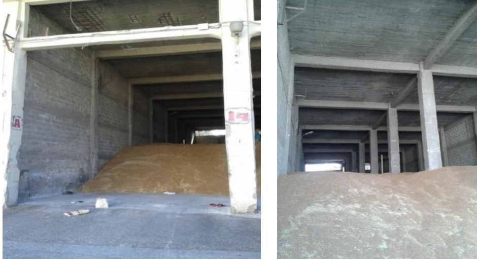
Şekil 3.3.Araştırma Deposu genel görünümü
