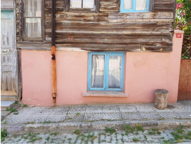
Resim 4.9. Zemin kat tip 1 (P3) ahşap pencere
