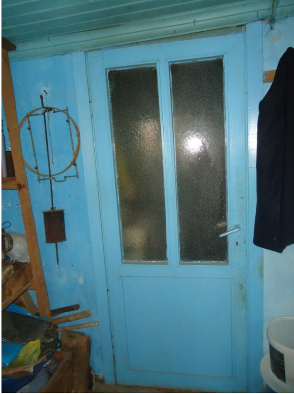
Resim 4.34. Z04 Depo giriş kapısı
