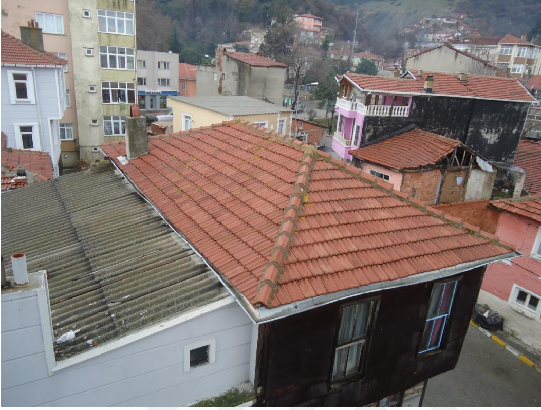
Resim 4.124. Kırma çatı görünümü ve marsilya tipi kiremit kaplama
