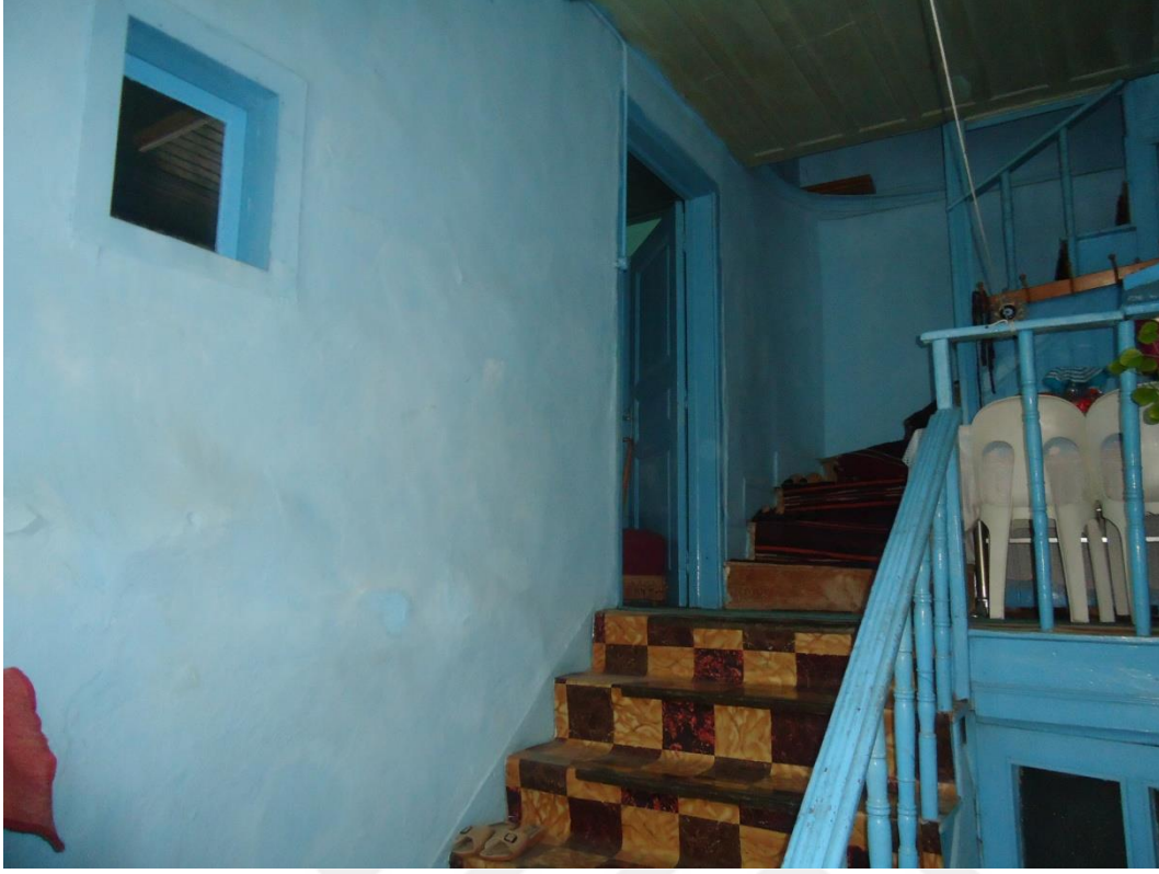
Resim 4.43. Z05 Giriş kuzey duvarındaki aydınlatma penceresi
