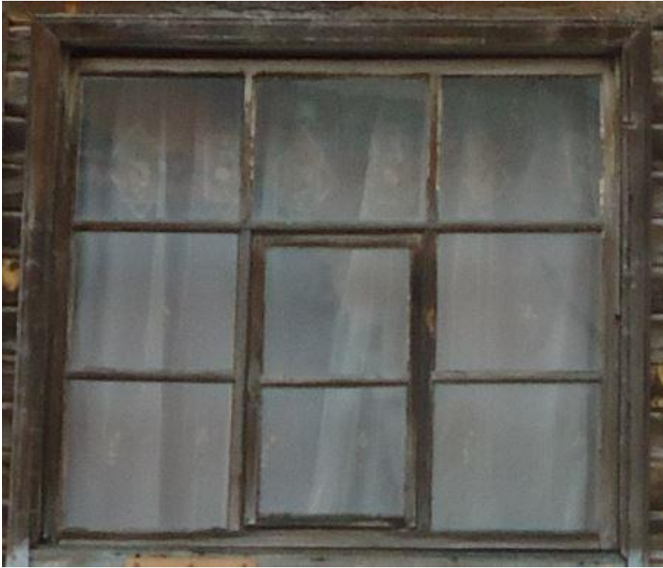
Resim 4.12. Zemin kat tip 4 (P8) ahşap pencere
