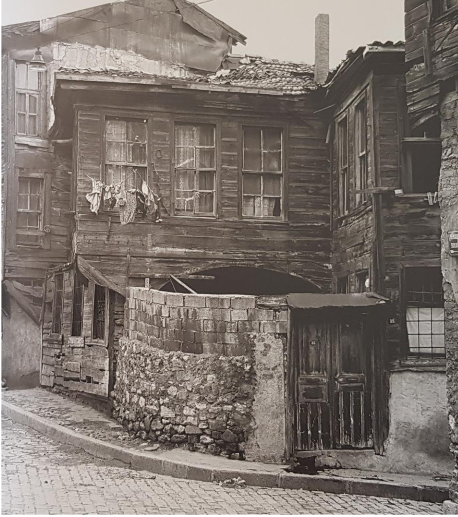
Resim 5.5. İbadethane Arkası Sokak'taki ahşap konak özgün duvar kotu, 1975 [26]
