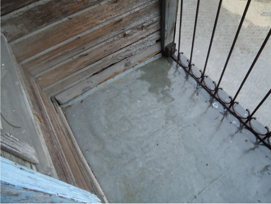
Resim 4.104. 202 Balkon zemin kaplaması
