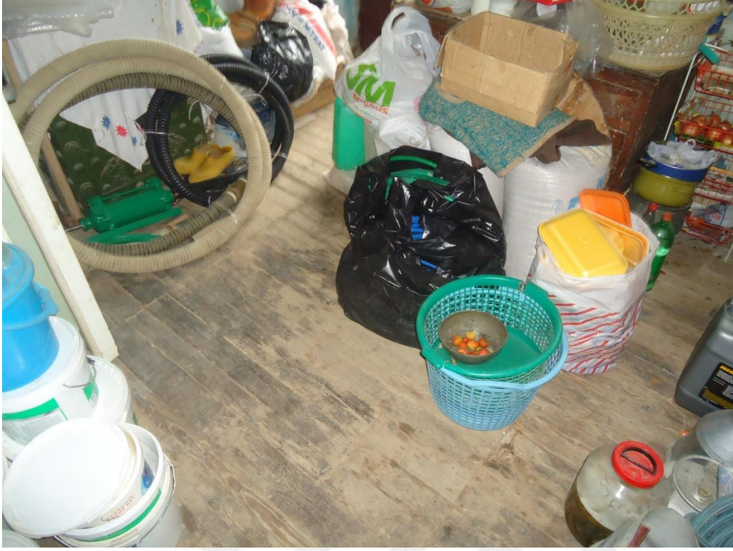
Resim 4.37. Z04 Depo zemin kaplaması
