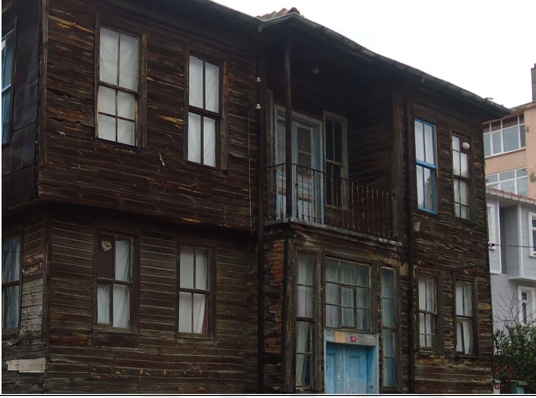
Resim 4.6. Ahşap cephe kaplaması altındaki tuğla dolgu duvar
