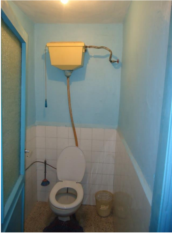
Resim 4.91. 106 Wc genel görünüm
