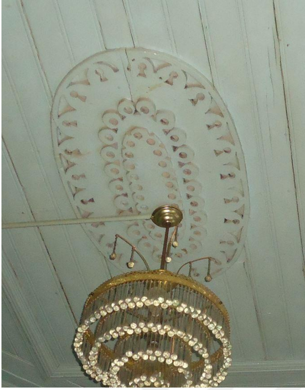
Resim 4.142. 203 Oda mahali ahşap tavan göbeği
