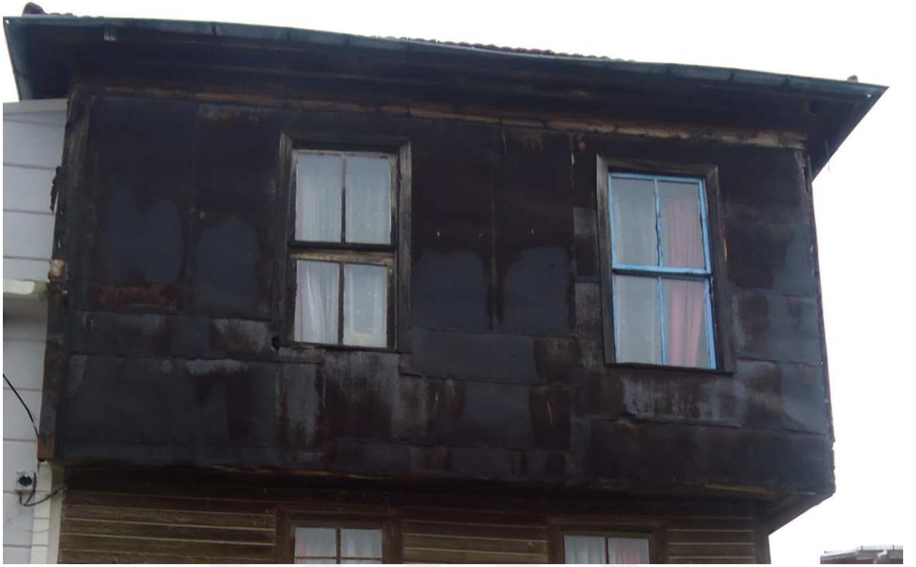
Resim 4.17. Sonradan yapılan niteliksiz sac kaplama
