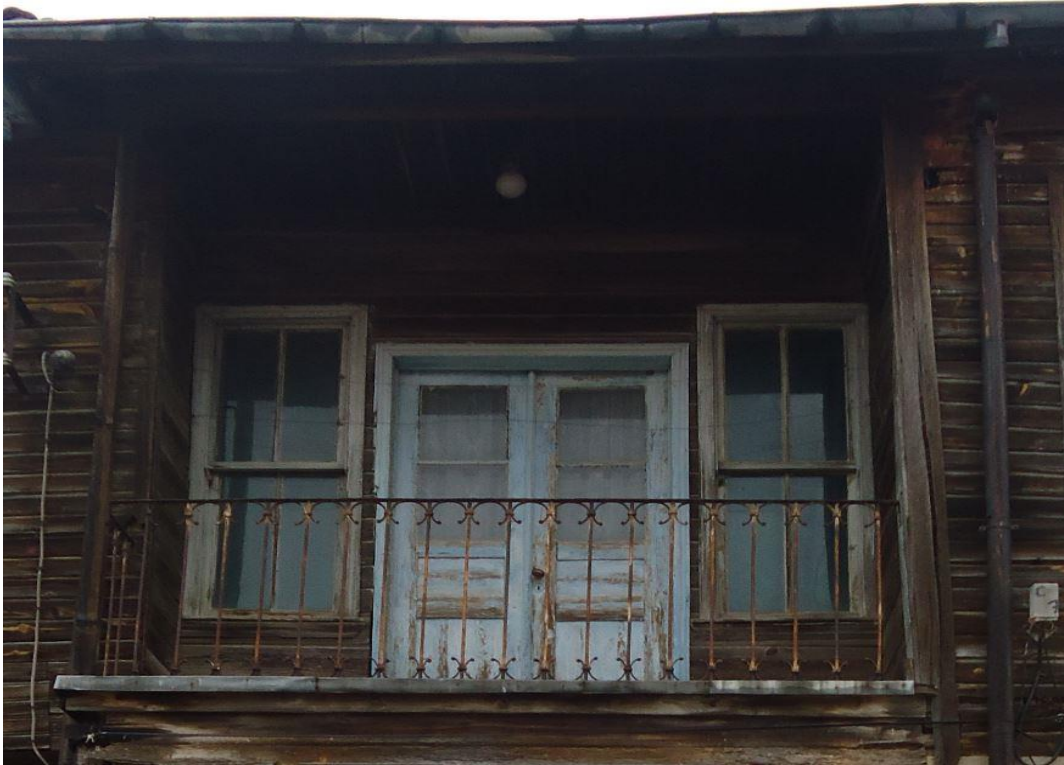
Resim 4.7. Çift kanatlı ahşap balkon kapısı
