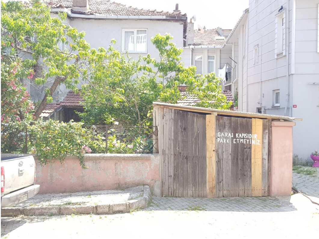
Resim 4.62. Z11 Garaj giriş kapısı
