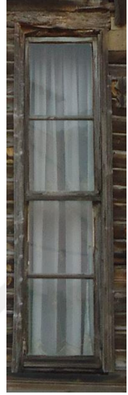
Resim 4.11. Zemin kat tip 3 (P7) ahşap giyotin pencere
