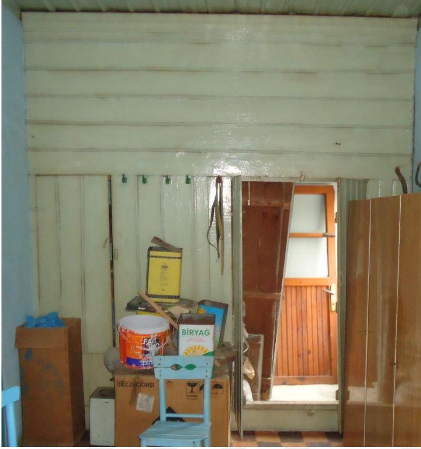
Resim 4.139. 204 Oda mahalindeki ahşap dolap görünümü
