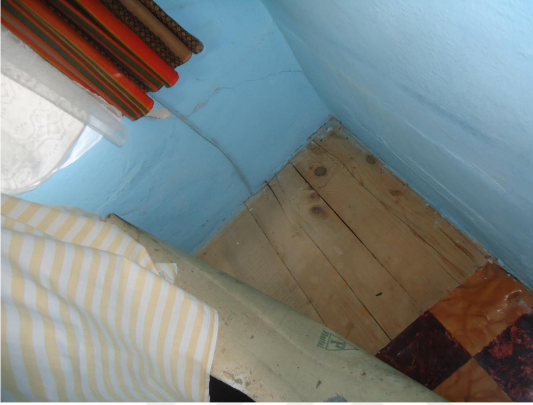
Resim 4.79. 103 Oda zemin kaplaması
