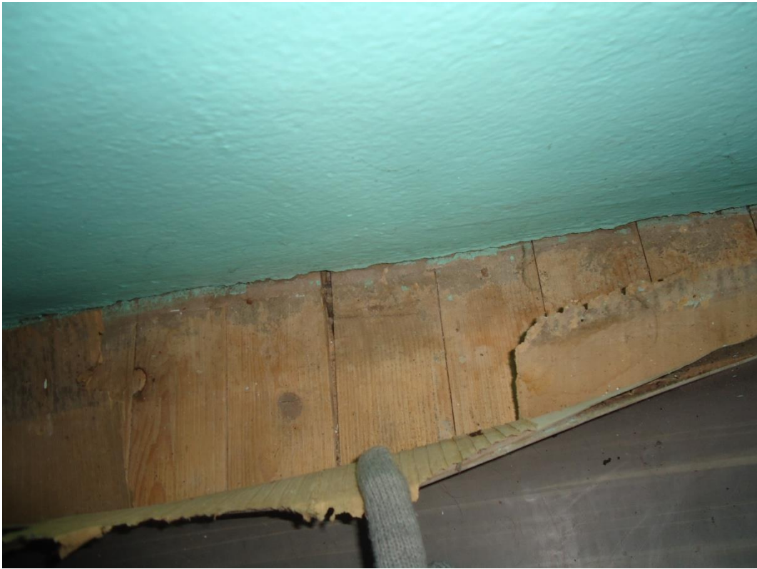
Resim 4.73. 102 Oda zemin kaplama
