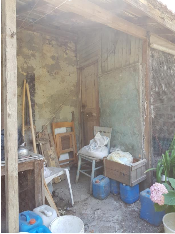
Resim 4.55. Z08 Odunluk güney duvarı
