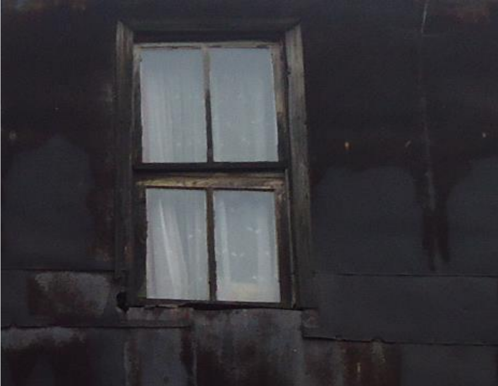
Resim 4.20. İkinci kat tip 2 (P13) ahşap giyotin pencere
