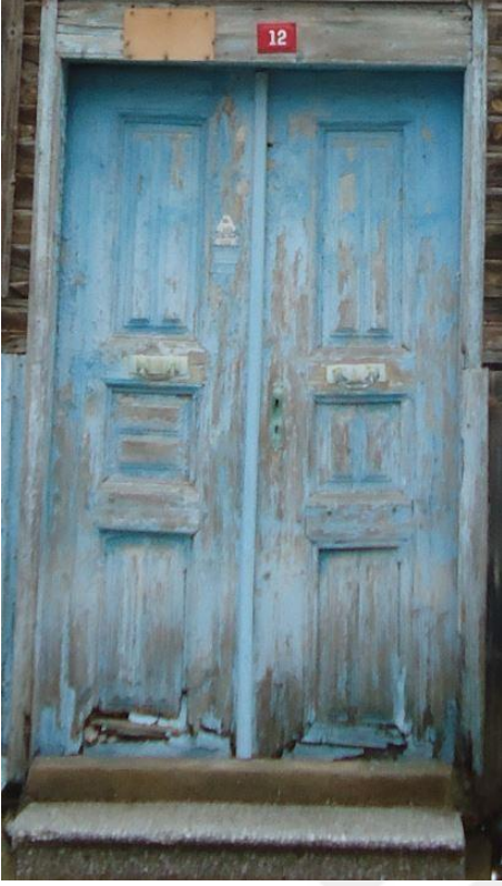
Resim 4.13. Zemin kat K2 çift kanatlı ahşap giriş kapısı
