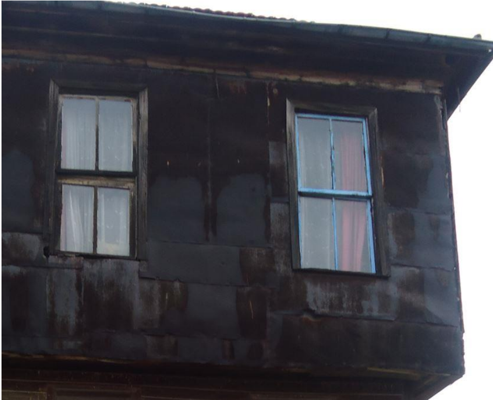
Resim 4.128. Kuzey cephe, yeniden yapılan pencere
