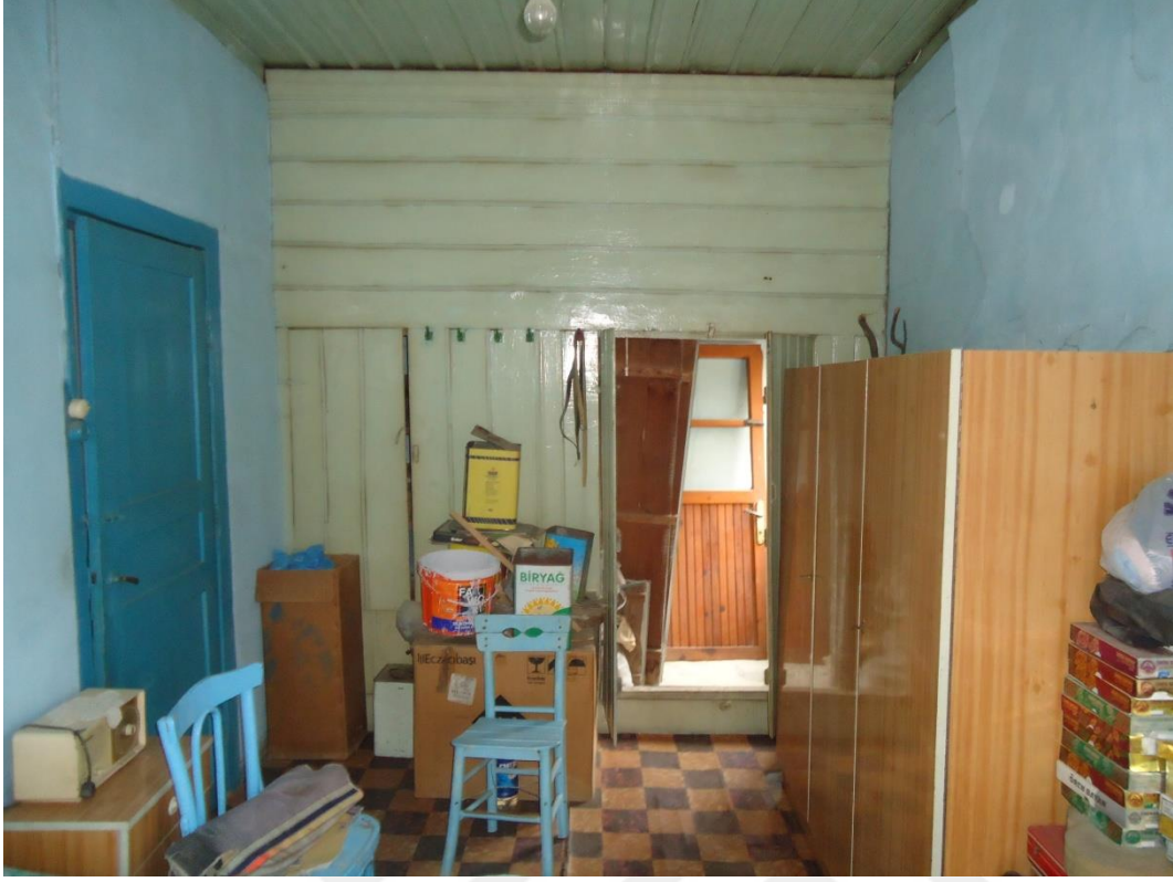
Resim 4.113. 204 Oda dođu duvarı, ahşap dolap
