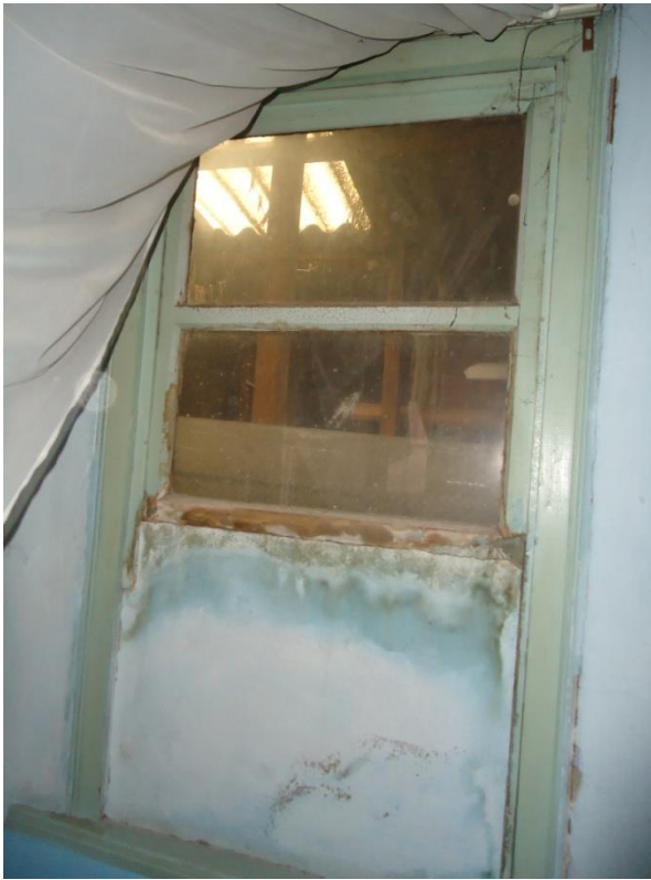
Resim 4.101. 201 Sofa dođu duvarı, ahşap giyotin pencere
