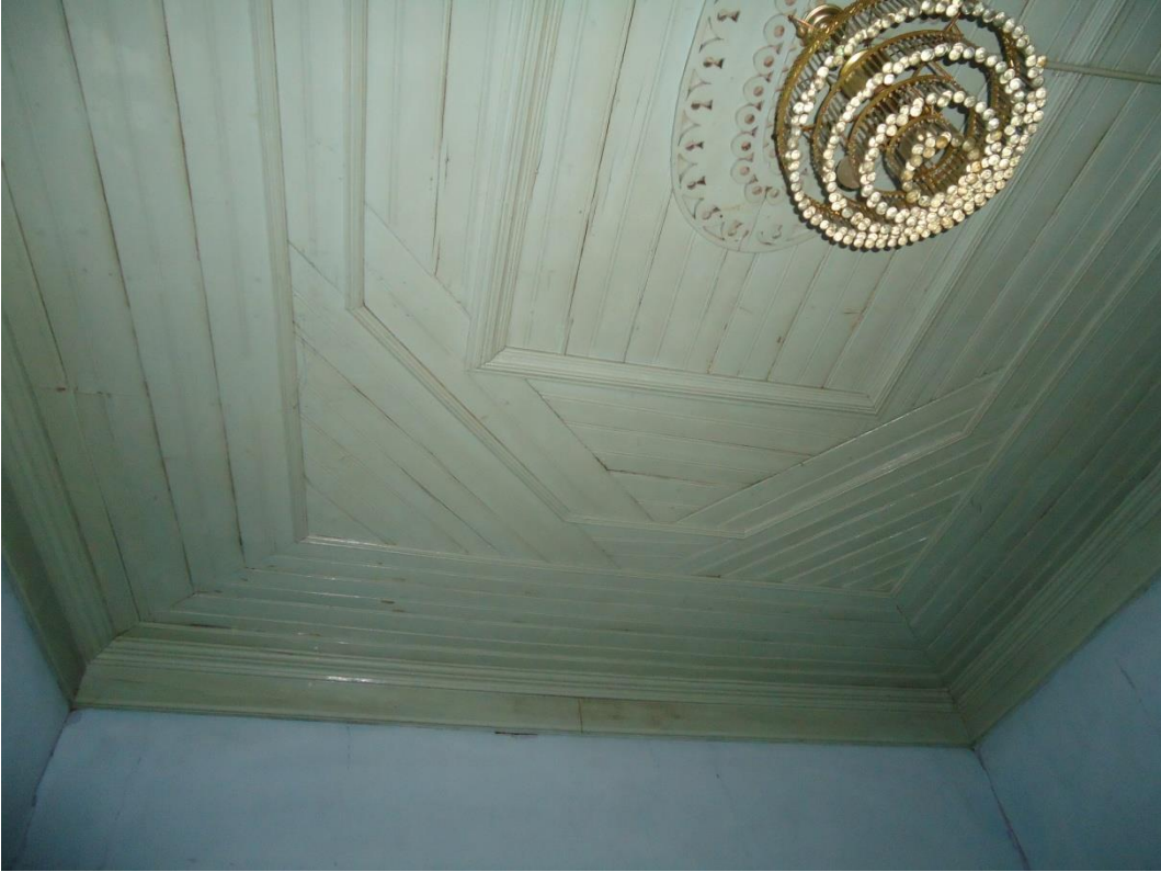
Resim 4.141. 203 Oda mahali tavan kaplaması görünümü
