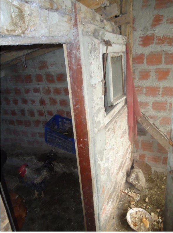
Resim 4.58. Z09 – Z10 Kumes tuğla duvarlar
