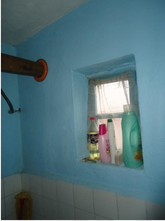
Resim 4.94. 107 Banyo havalandırma penceresi
