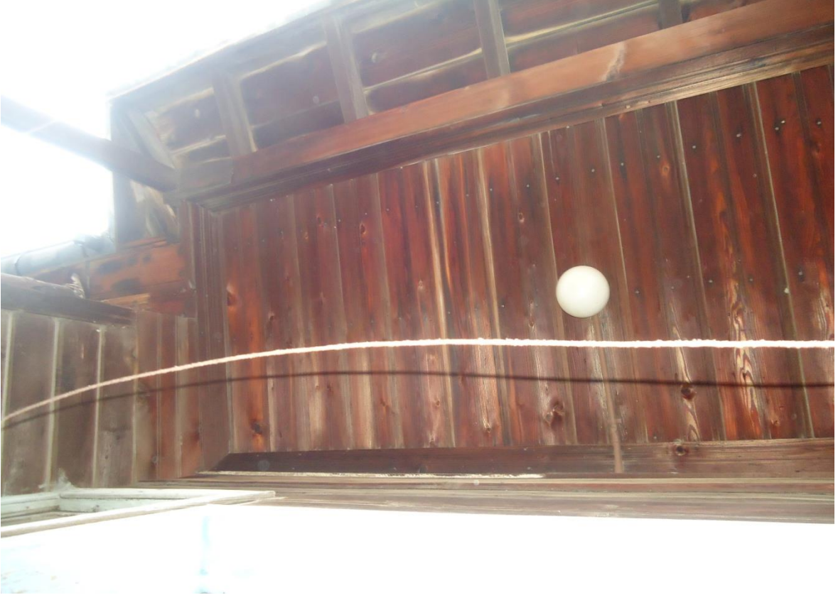
Resim 4.106. 202 Balkon tavan kaplaması
