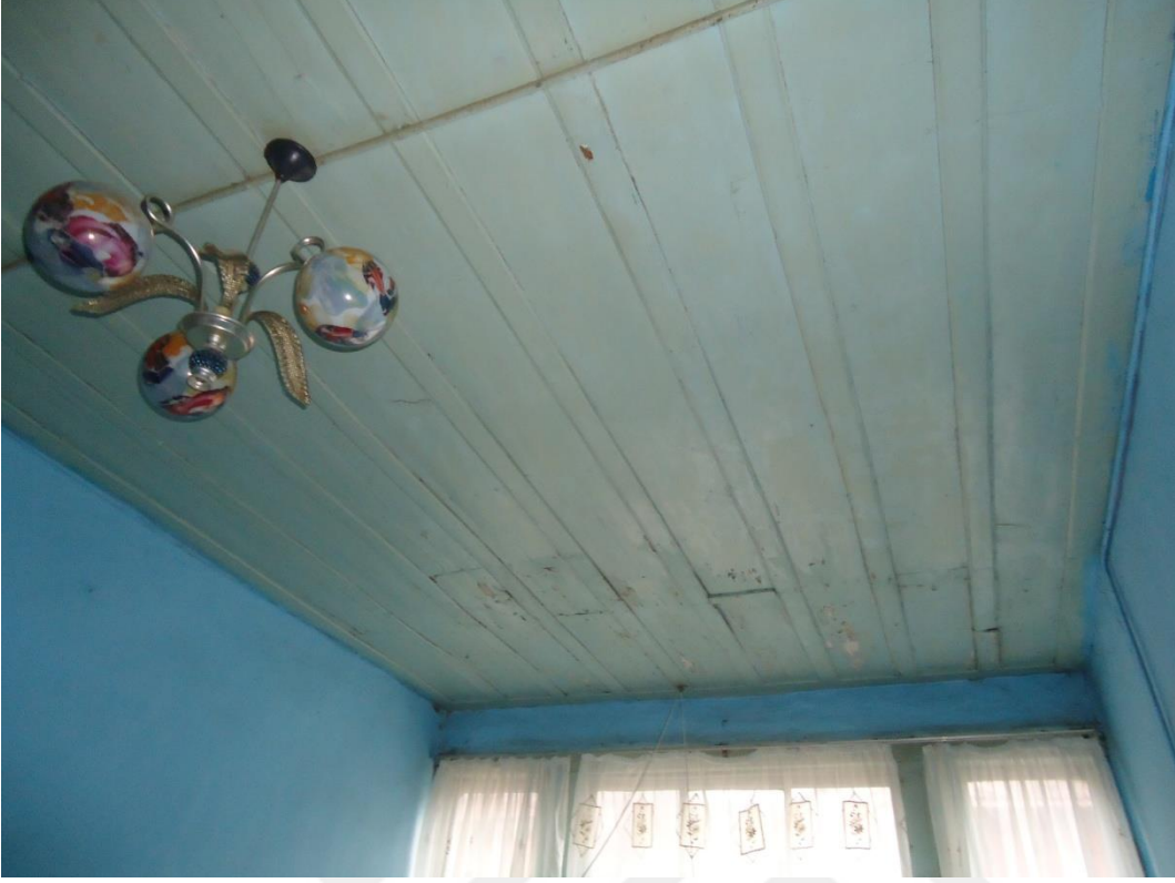
Resim 4.140. Z05 Giriş mahali tavan kaplaması görünümü
