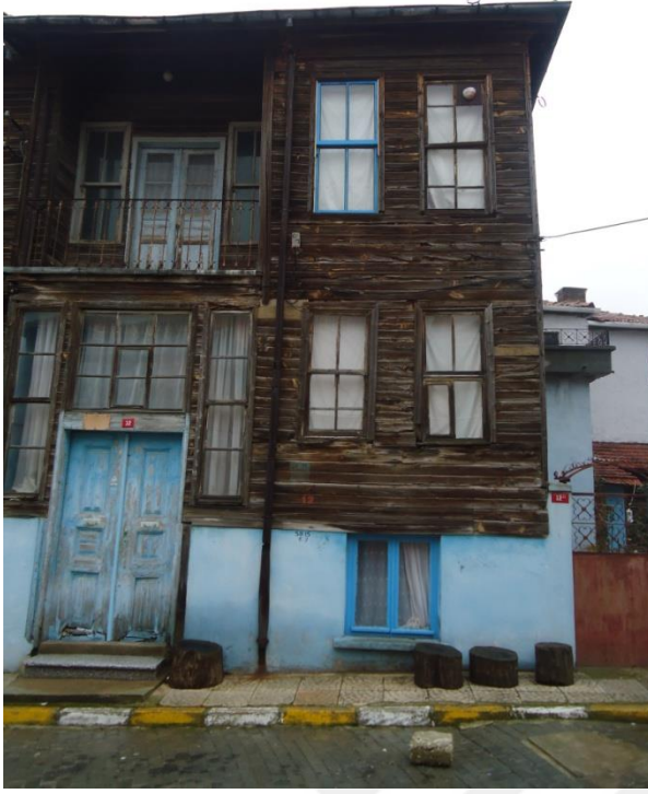
Resim 4.126. Yeni açılan pencere ve yeniden yapılan pencere
