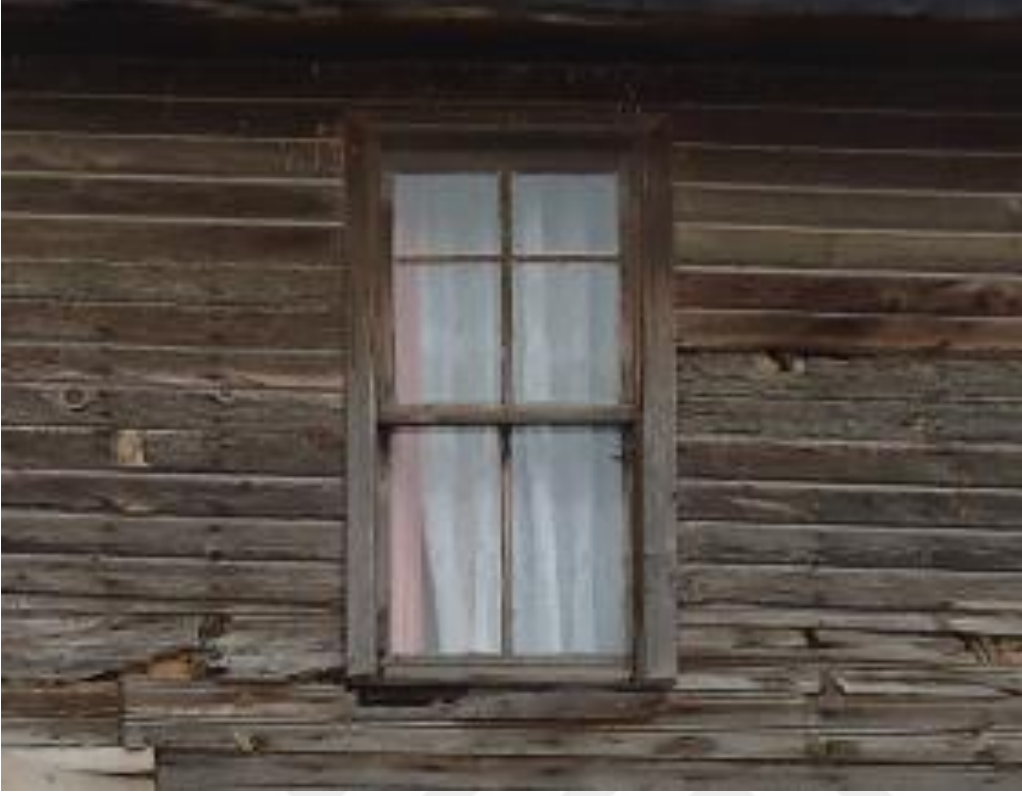
Resim 4.19. Birinci kat tip 2 (P6) ahşap giyotin pencere
