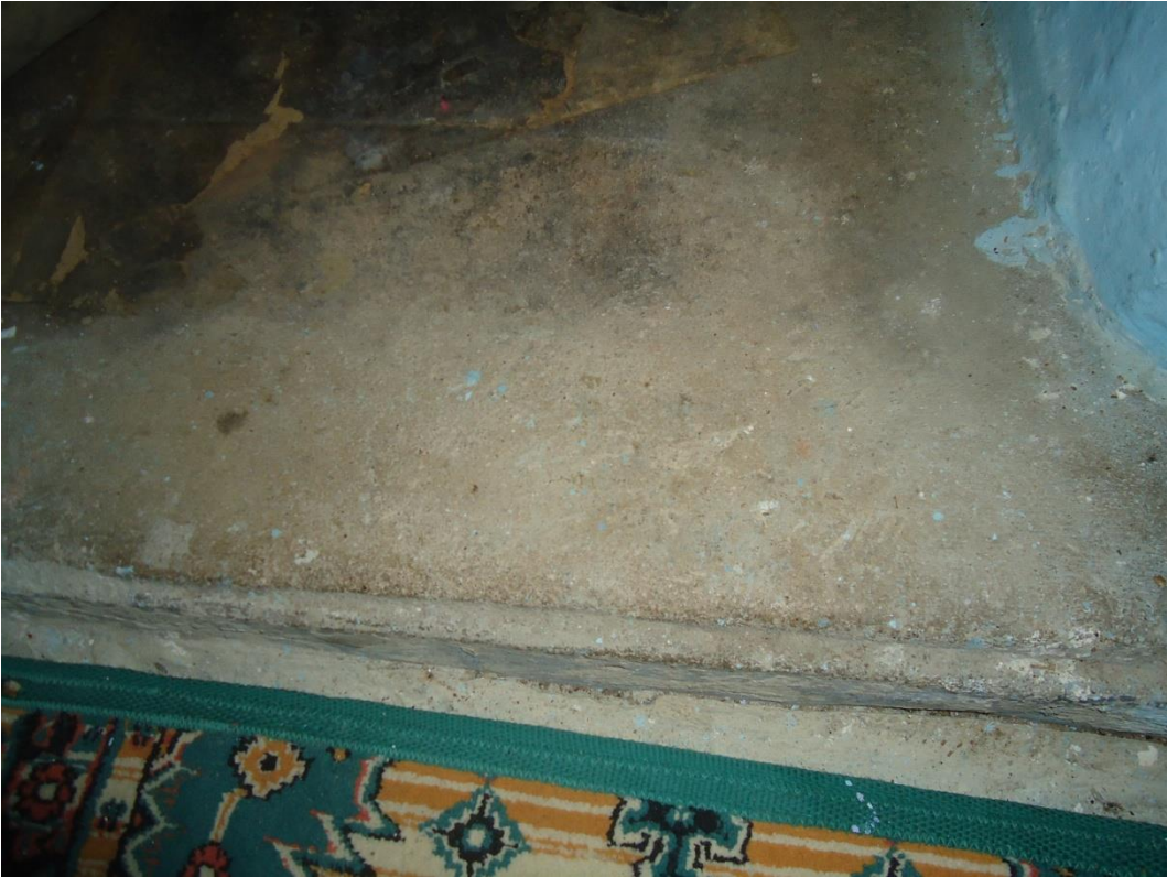
Resim 4.84. 104 Hol zemin malzemesi
