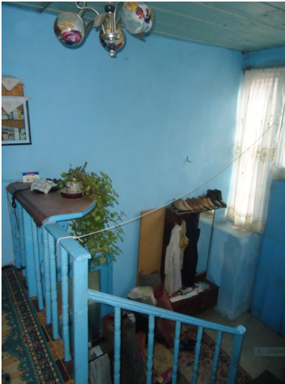
Resim 4.44. Z05 Giriş güney duvarı
