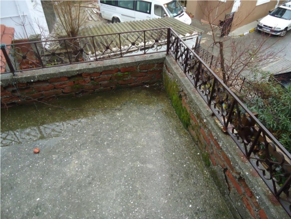
Resim 4.119. 207 Teras parapet üzeri ferforje korkuluk
