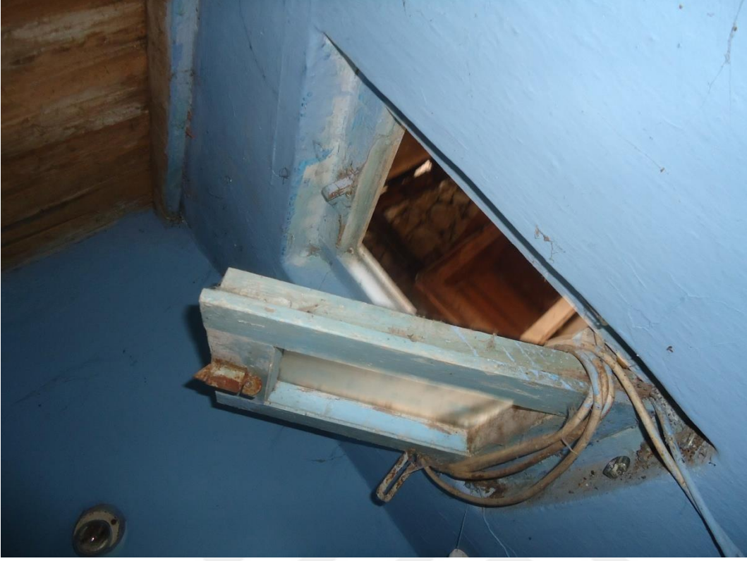
Resim 4.50. Z07 Wc güney duvarındaki havalandırma penceresi
