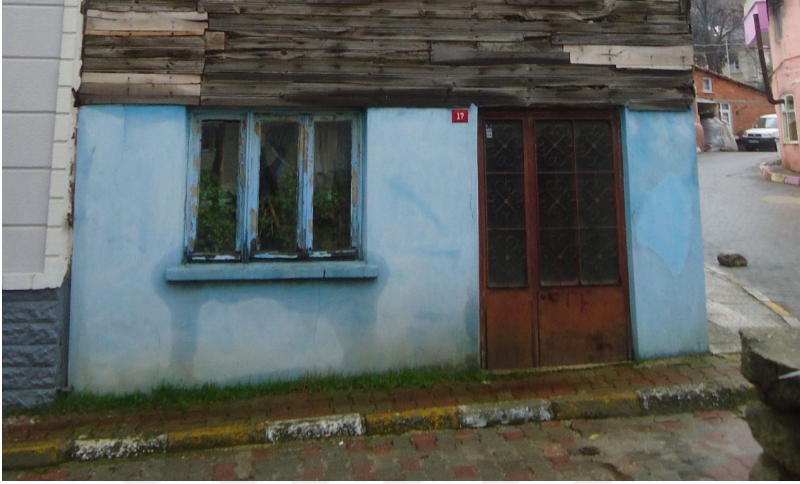
Resim 4.129. Kuzey cephe, niteliksiz onarım ile deęişen pencere
