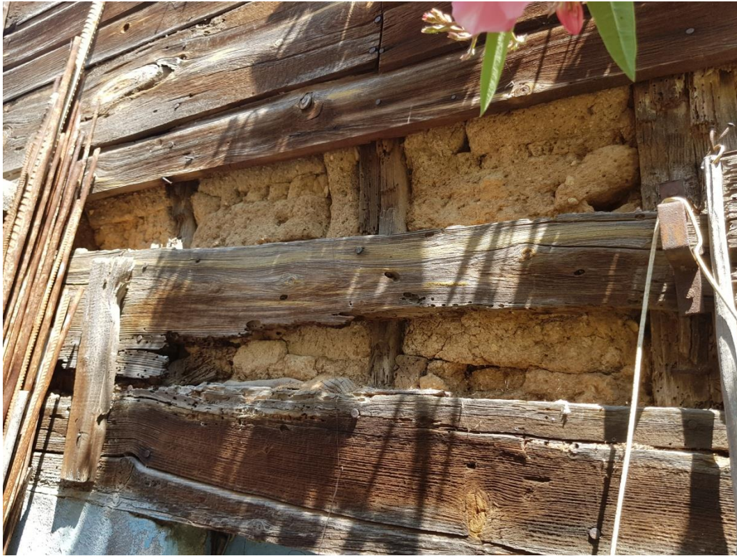
Resim 4.121. Ahşap çatkı arası kerpiç duvar
