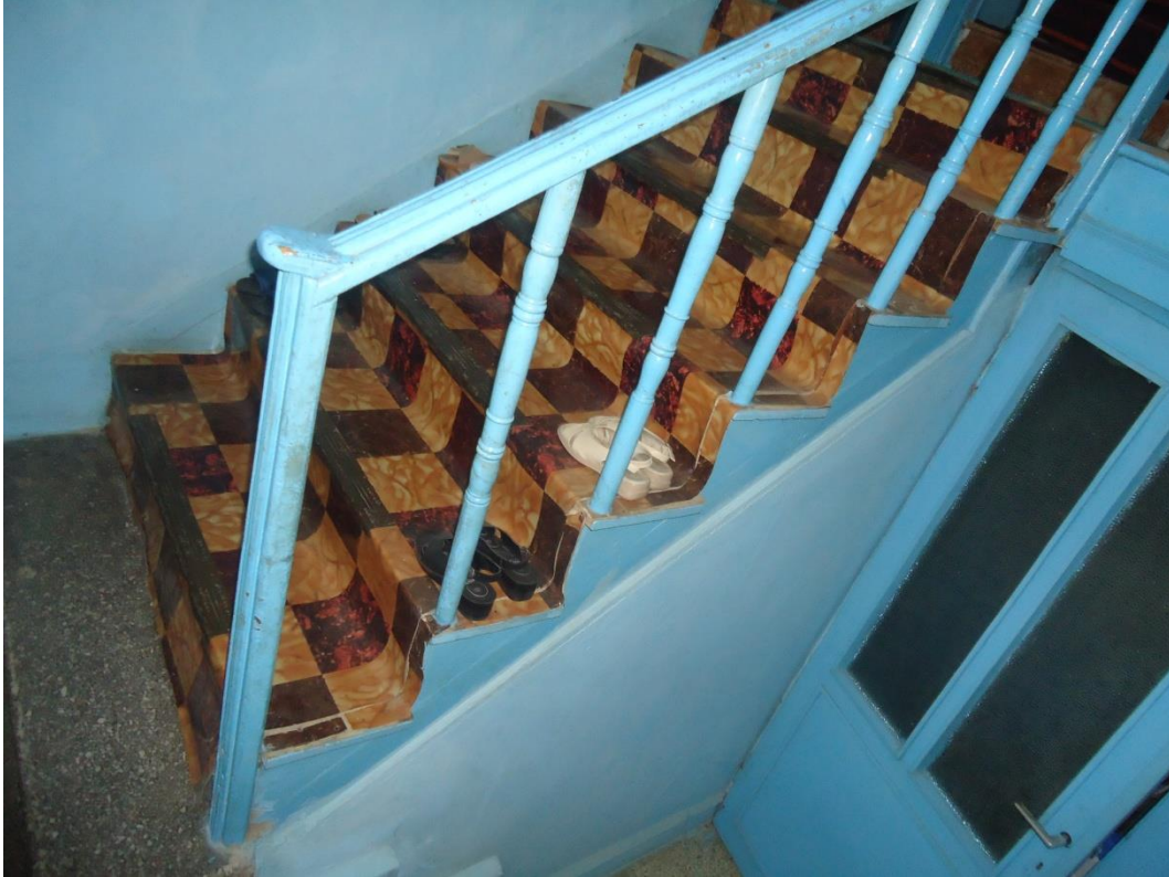
Resim 4.135. Z05 Giriş mahalindeki ahşap merdiven görünümü
