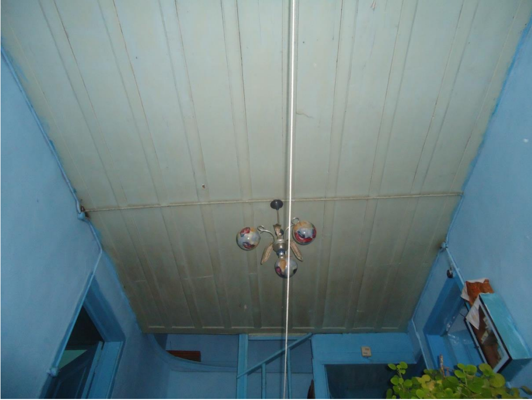
Resim 4.47. Z05 Giriş tavan kaplaması
