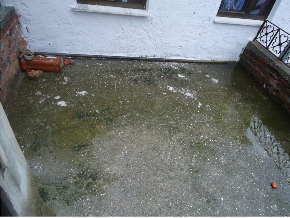
Resim 4.118. 207 Teras genel görünüm
