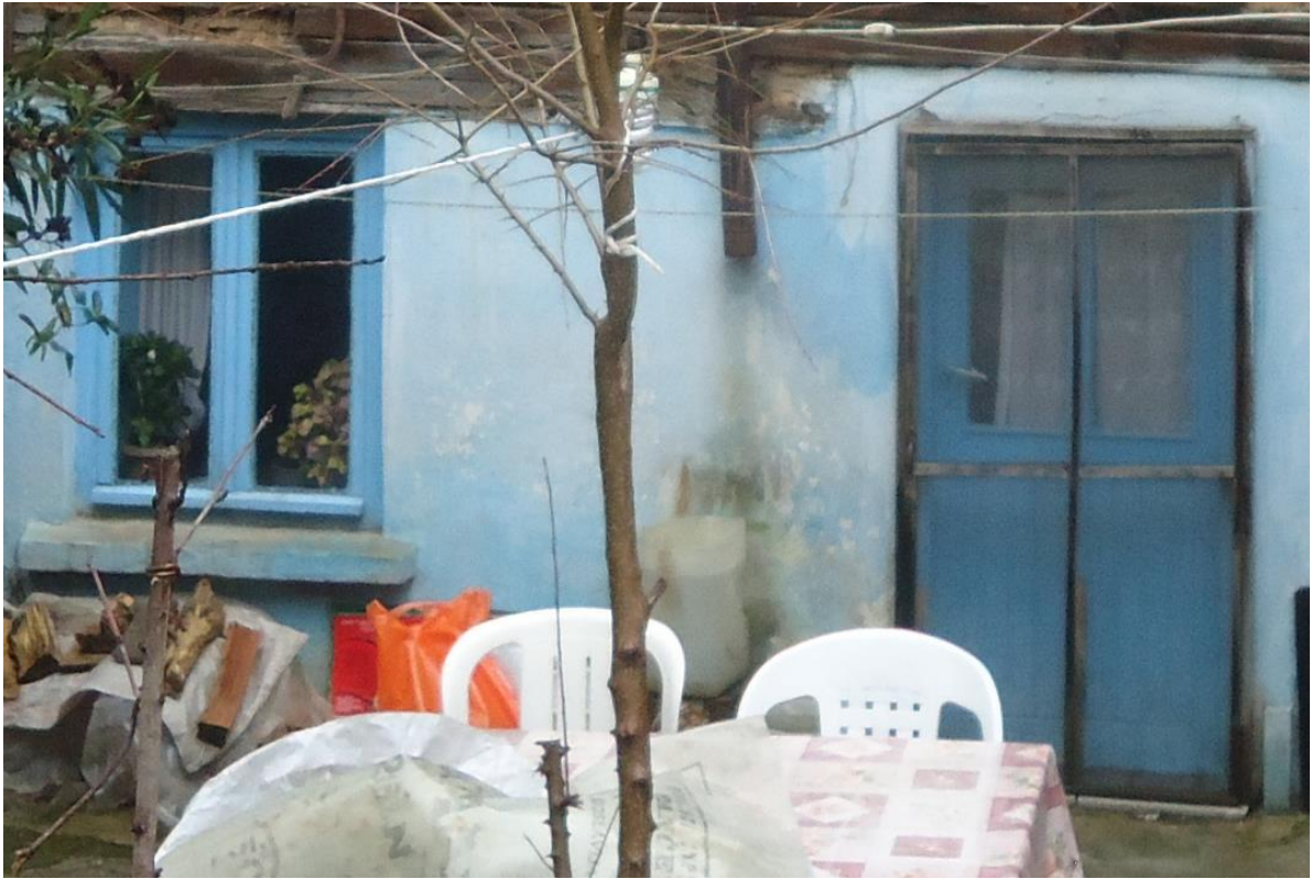
Resim 4.25. Zemin kat tip 1 (P2) penceresi ve K1 ahşap giriş kapısı
