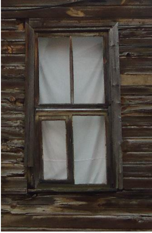
Resim 4.10. Birinci kat tip 2 (P6) ahşap giyotin pencere
