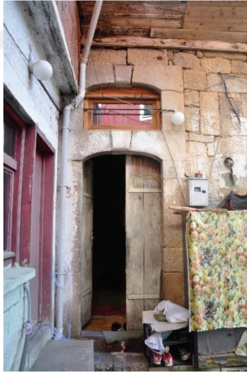
Resim 4.78. DK3 kapısı dıştan görünüş
