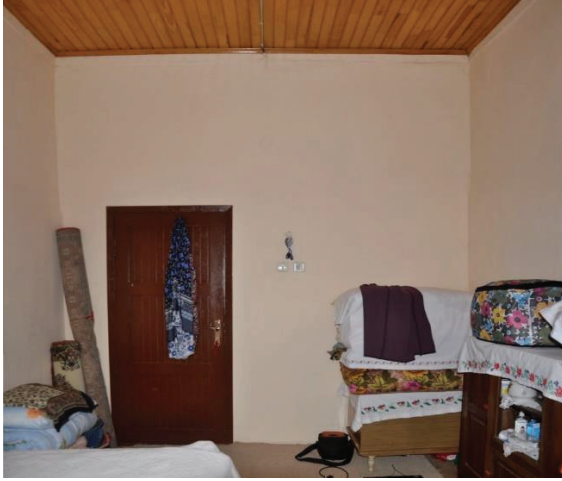
Resim 4.47. Z03, DV1 duvarı
