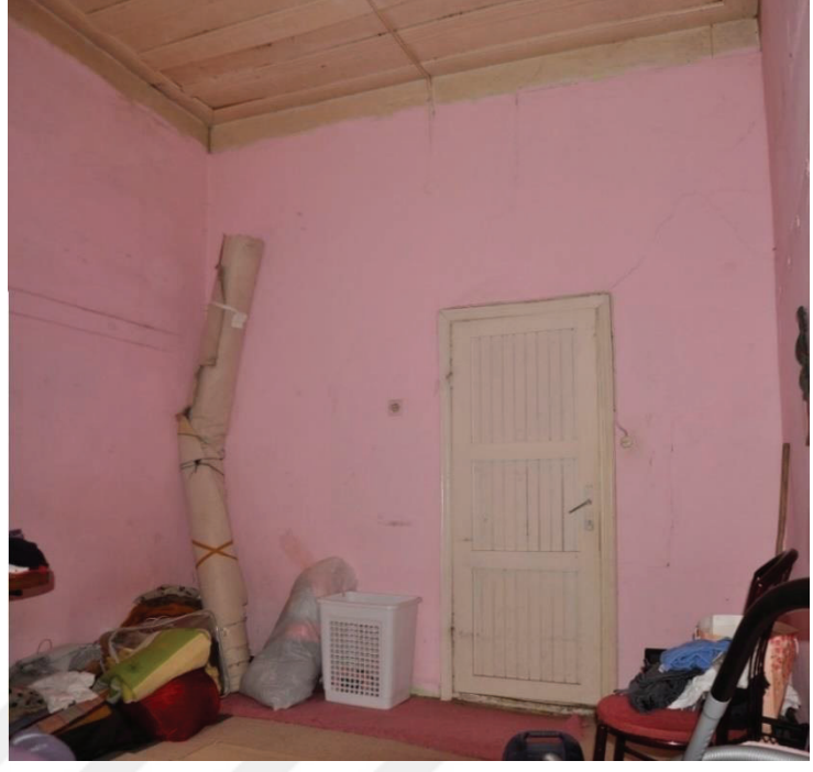
Resim 4.72. Z08, DV1 duvarı
