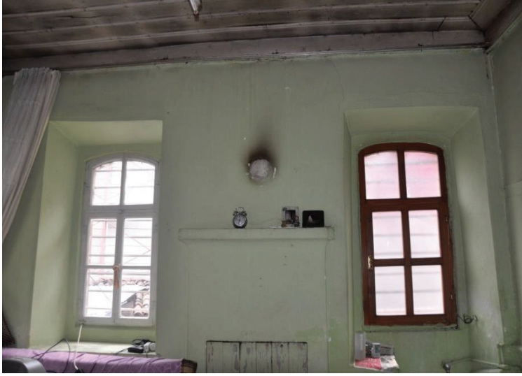
Resim 4.67. Z07, DV3 duvarı
