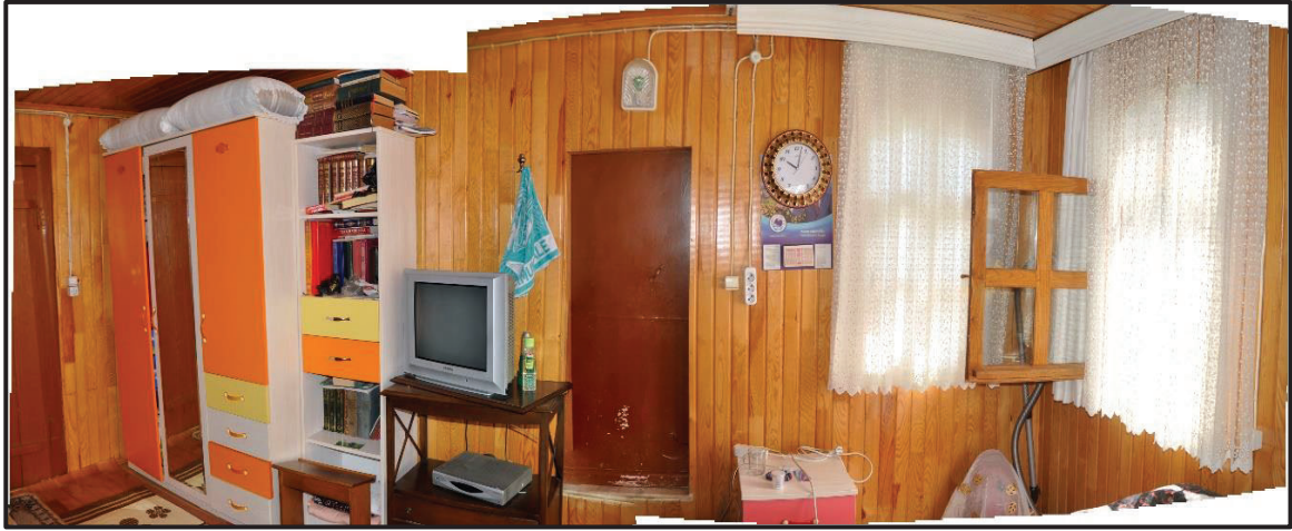
Resim 4.110. 1K03 mahali DV2 duvarı
