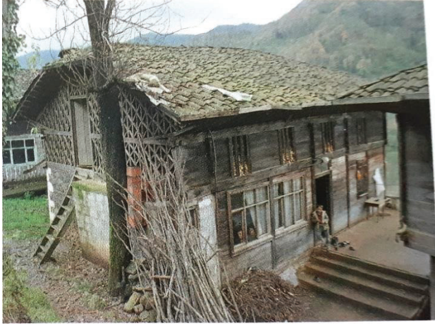
Resim 5.3. Rasim Politoğlu evi; muska duvar ve ahşap yığma duvar kullanımı [23]
