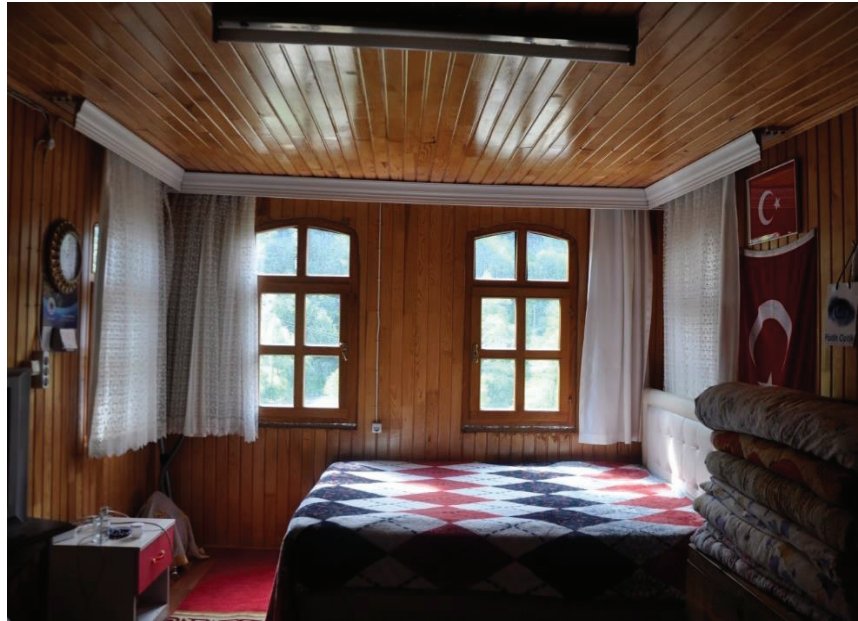
Resim 4.114. 1K03, DV3 duvarı
