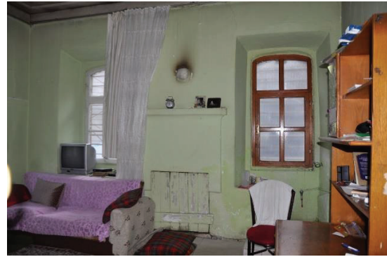
Resim 4.66. Z07, DV3 duvarı
