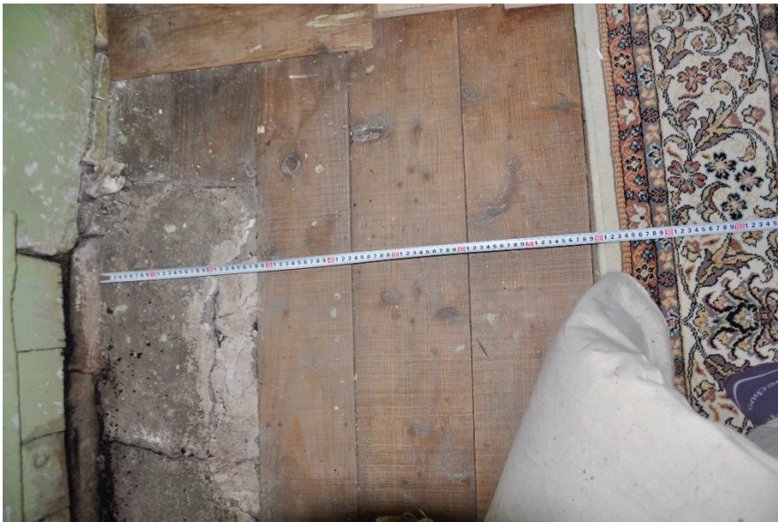
Resim 4.125. Zemin kat Z07 mekanı zemin döşemesi
