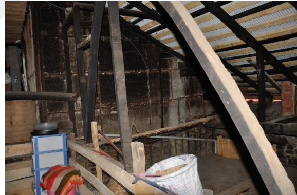
Resim 4.88. 1K04 güneybatı duvarı
