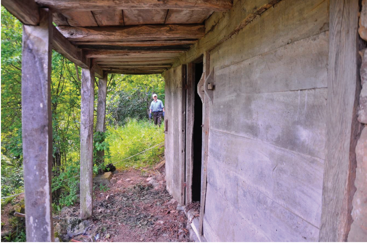
Resim 3.8. 6 numaralı konutta blok ahşap dolma karkas duvar örneği
