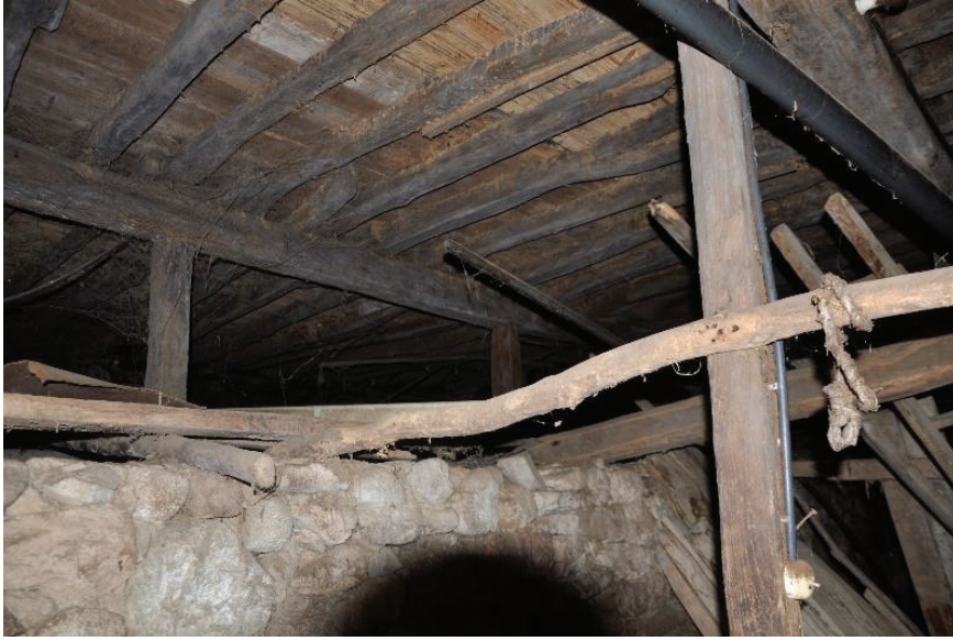
Resim 4.124. Bodrum kat tavan döşemesi
