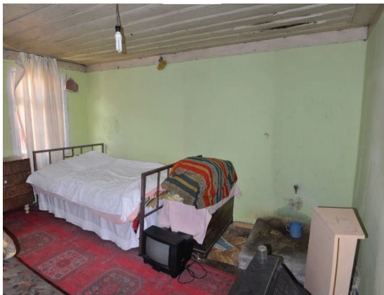
Resim 4.122. 1K04, DV4 duvarı
