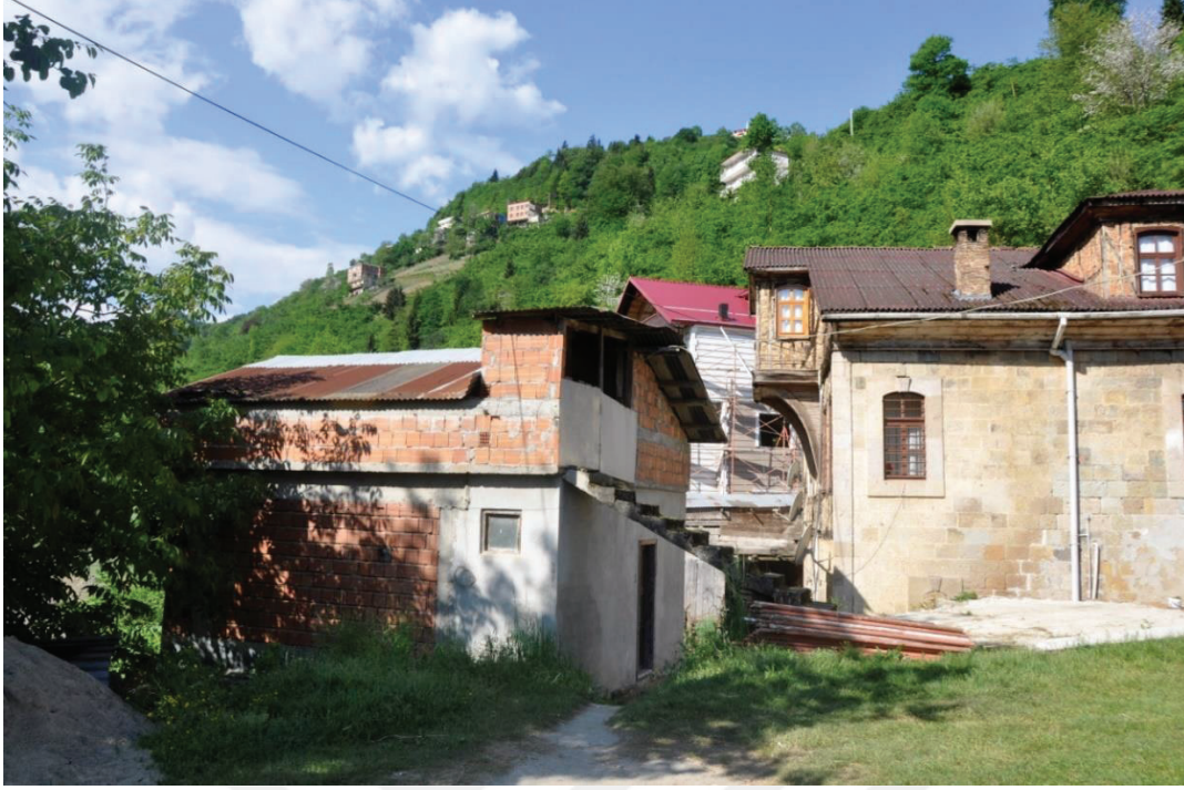
Resim 4.4. Kaba inşaat halinde duran yapı
