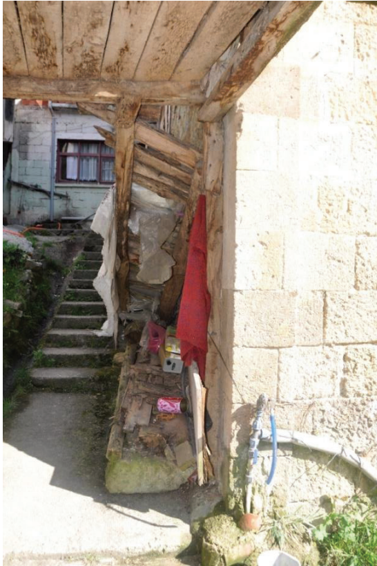
Resim 4.26. Depo alttan görünüş
