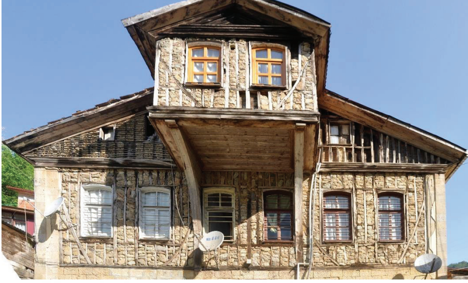
Resim 4.135. Güneydoğu cephesi pencereler
