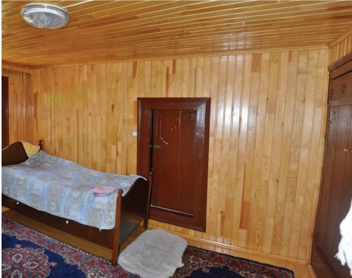
Resim 4.104. 1K02 mekanı DV4 duvarı
