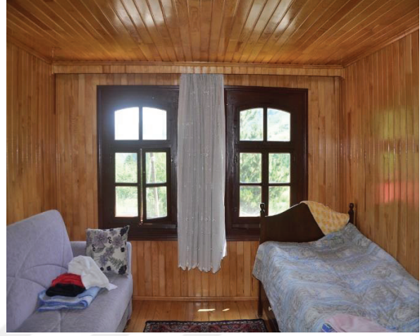
Resim 4.103. 1K02 mekanı DV3 duvarı
