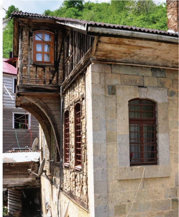
Resim 4.143. Ahşaptaki renk değişimi ve deformasyon
