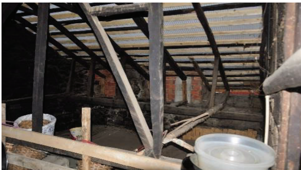
Resim 4.89. Çatının güneybatı bölümü
