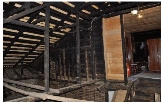
Resim 4.90. 1K04 kuzeydoğu duvarı
