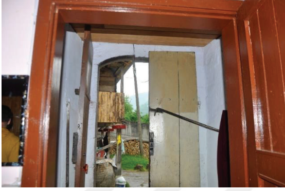
Resim 4.37. Z01 mahalinden görünüş
