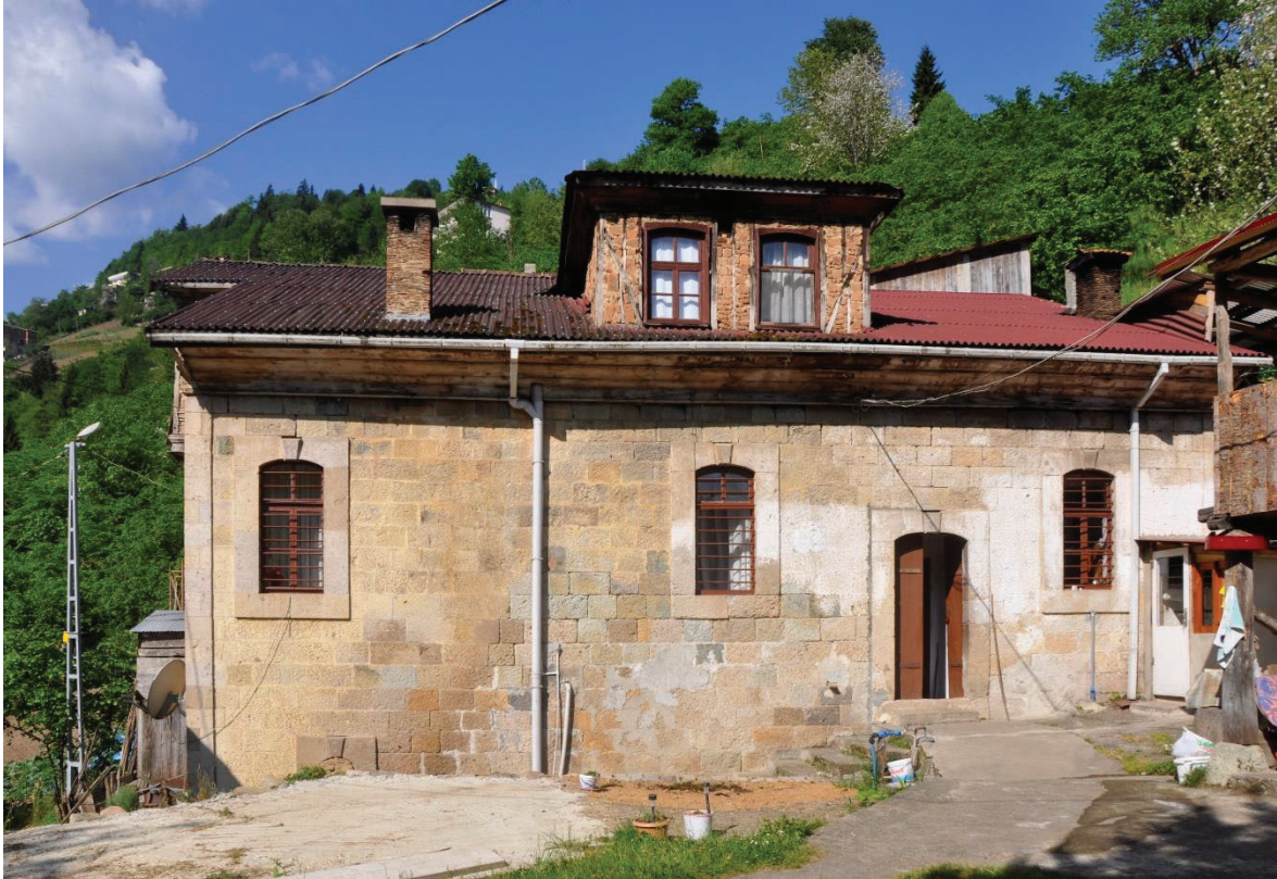
Resim 4.134. Kuzeydoğu cephesi pencereler
