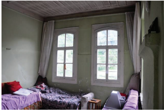
Resim 4.65. Z07, DV2 duvarı
