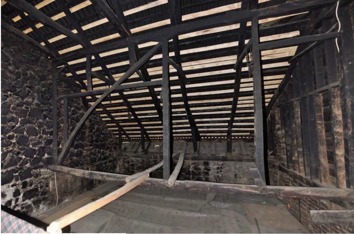
Resim 4.91. Çatının kuzeybatı bölümü
