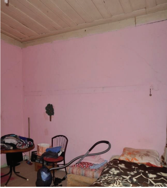
Resim 4.73. Z08, DV2 duvarı
