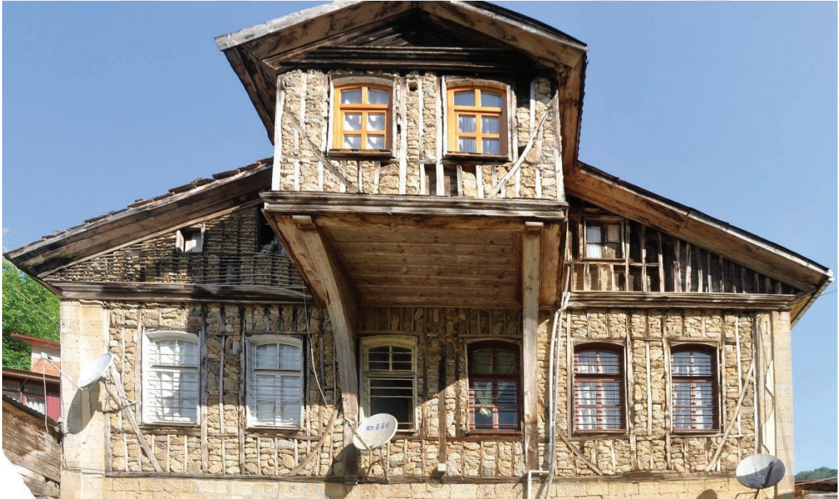
Resim 4.22. DV5 ve DV6 duvarı
