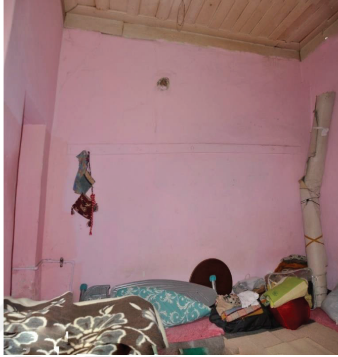
Resim 4.76. Z08, DV4 duvarı
