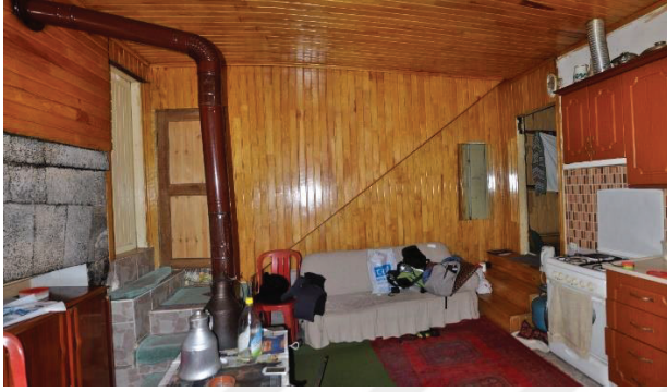
Resim 4.81. Z09 mahali DV3 duvarı
