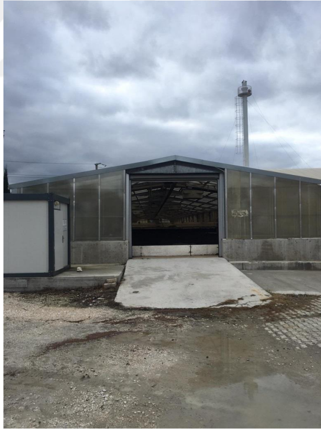
Şekil 0.8. Solar çamur kurutma tesisi
