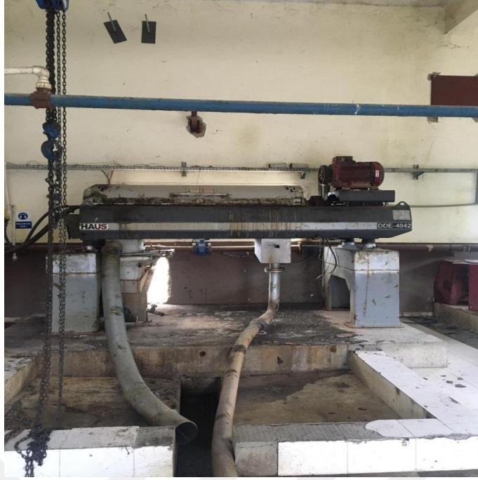
Şekil 0.7. Çamur çekim ekipmanı dekanter
