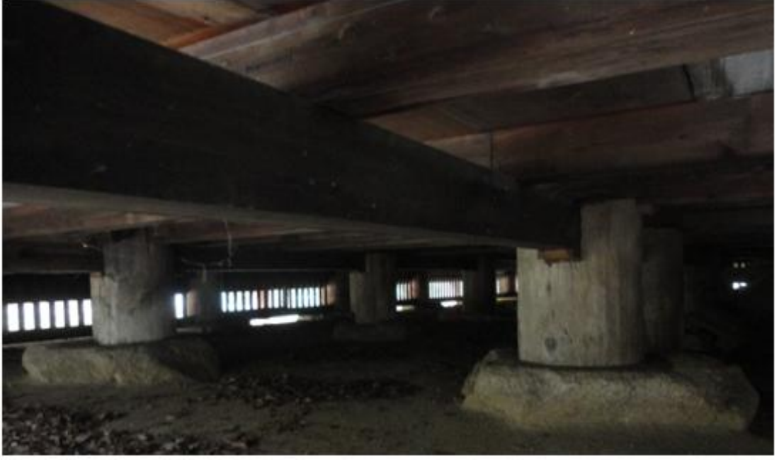
Şekil 3.4. Kolonları destekleyen temel taşları (Itagaki, 1998; Ohmori, 1998; Masatsugu ve Zentaro, 2013; Locher vd, 2015)
