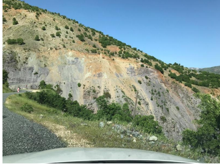
Şekil 3.8. Doğanbağı-Kalaba yolu 04.04.2019 tarihinde meydana gelen depremden sonra oluşan heyelandan bir tanesine ait görünüm
