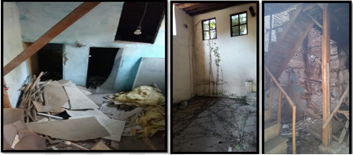
Şekil 5.3: Çalışma Alanındaki Yapılara Ait Görüntüler (Karaarslan, 2019).
