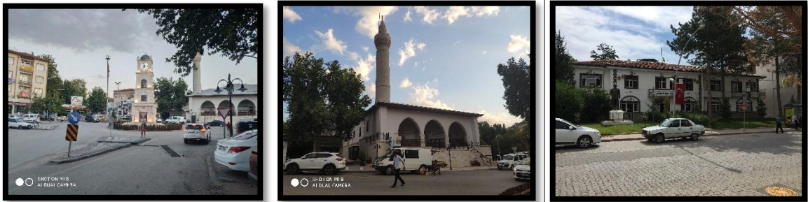
Şekil 4.17: Saat kulesi, Camii Kebir, eski belediye binası (Karaarslan, 2019).
