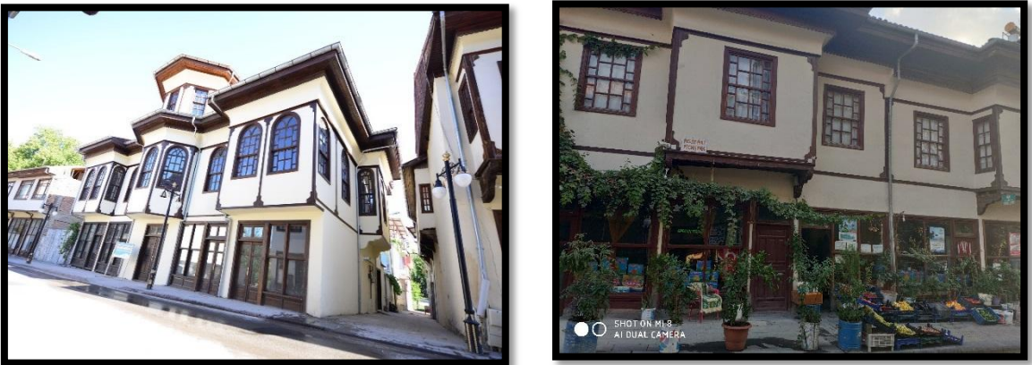
Şekil 5.6: Çalışma Alanındaki Yapılara Ait Görüntüler (Karaarslan, 2019).
