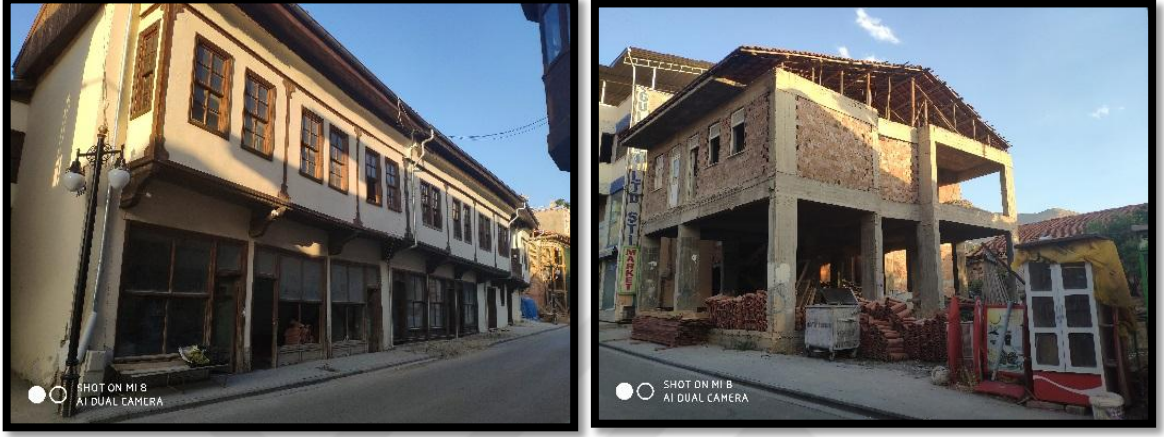
Şekil 5.5: Çalışma Alanındaki Yapılara Ait Görüntüler (Karaarslan, 2019).
