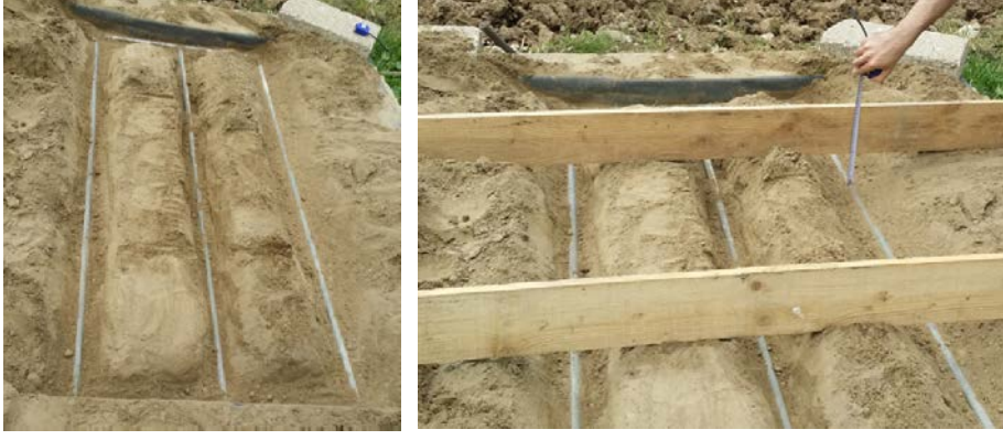
Şekil 3.34. Galvanizli demir borudan hazırlanan kılavuz yerleşimi
