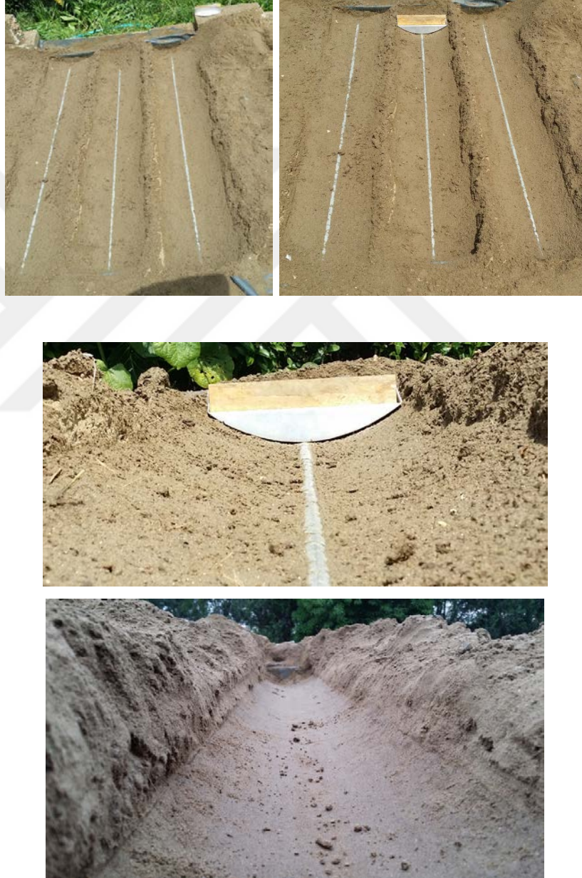
Şekil 3.37. Sürgü kullanılarak hazırlanan bariyer yerleştirilecek toprak profili
