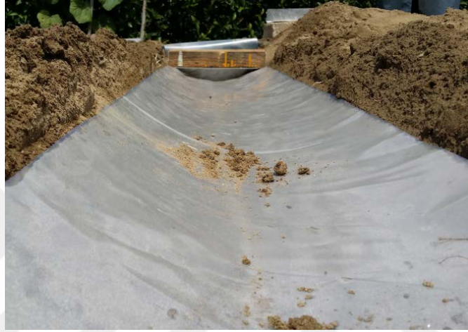
Şekil 3.39. Hazırlanan toprak profiline bariyer yerleşimi
