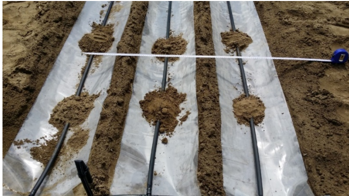
Şekil 3.40. Boru ve bariyerler kapatılmadan önce son ölçülendirme
