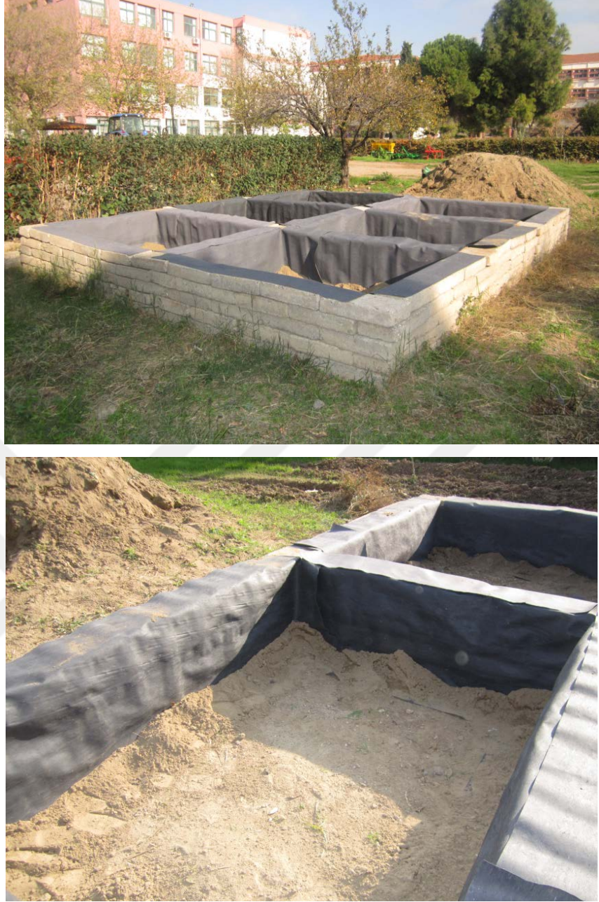
Şekil 3.5. PVC su yalıtım örtüsü ile kaplanmış yetiştirme ortamları
