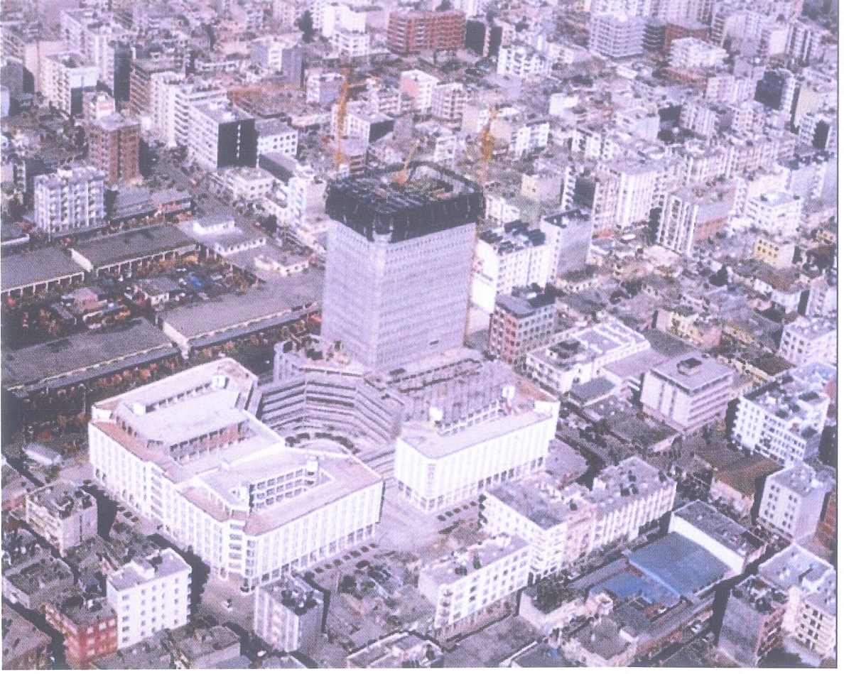
Şekil 4.11. Metropol ve 52 Katlı yapı inşaatı
