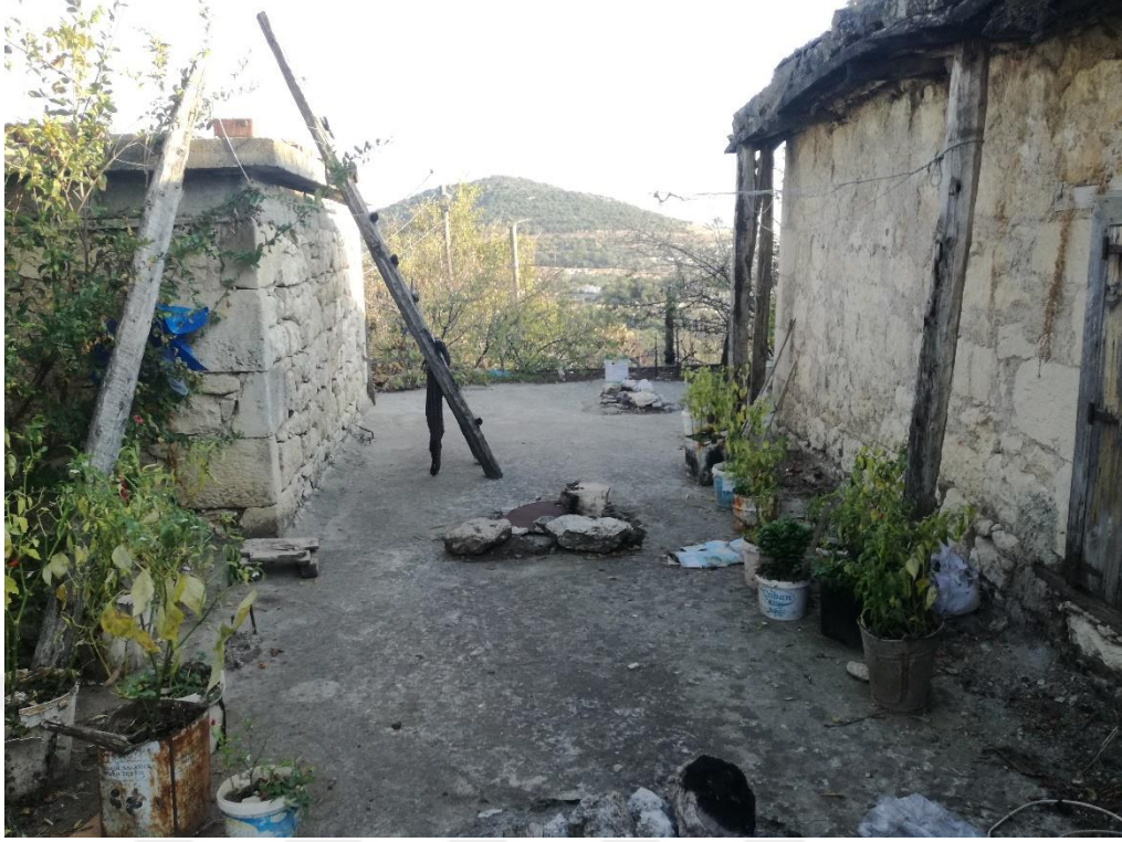
Şekil 3.8. 836 parselde bulunan geleneksel evin Kuzeydoğu görünüşünün fotoğrafı
