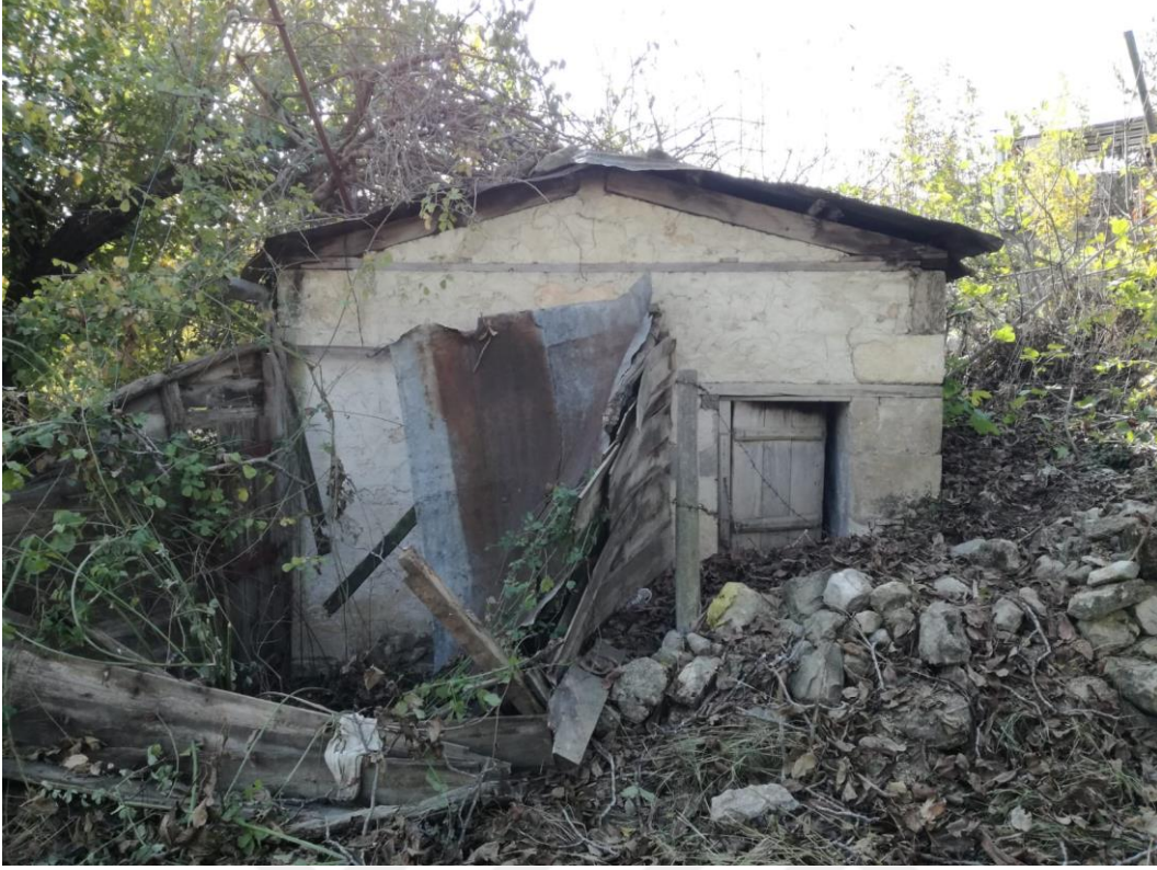
Şekil 3.24. 301 parselde bulunan geleneksel evin Kuzeydoğu görünüşünün fotoğrafı
