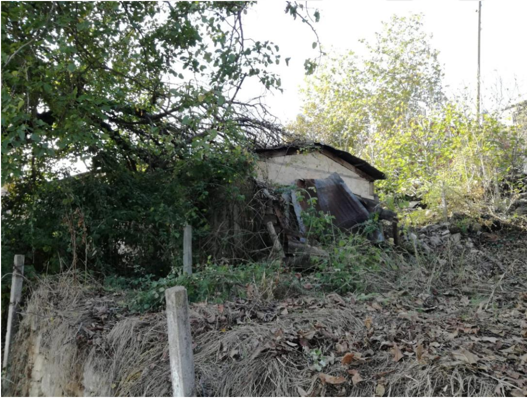
Şekil 3.25. 301 parselde bulunan geleneksel evin Kuzeydoğu görünüşünün fotoğrafı
