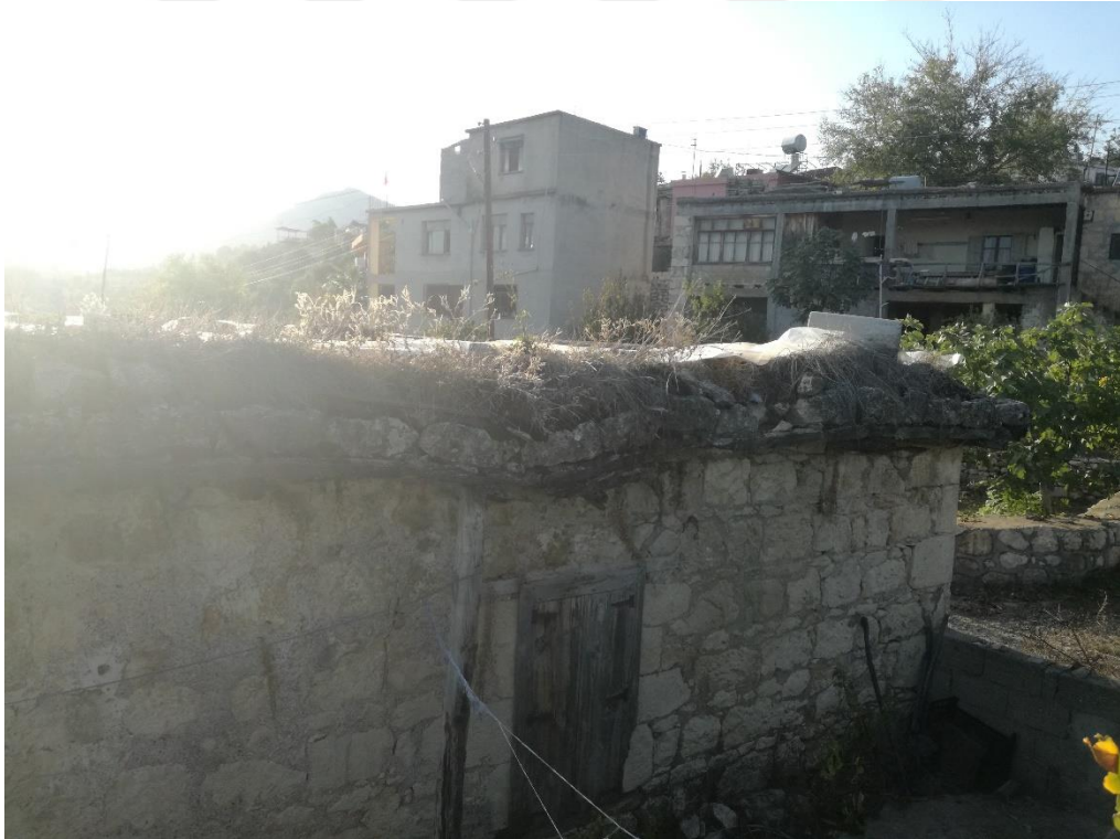
Şekil 3.9. 836 parselde bulunan geleneksel evin Kuzeydoğu görünüşünün fotoğrafı
