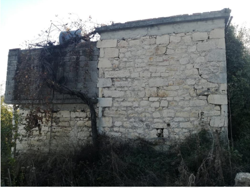
Şekil 3.18. 833 parselde bulunan geleneksel evin Kuzeydoğu görünüşünün fotoğrafı
