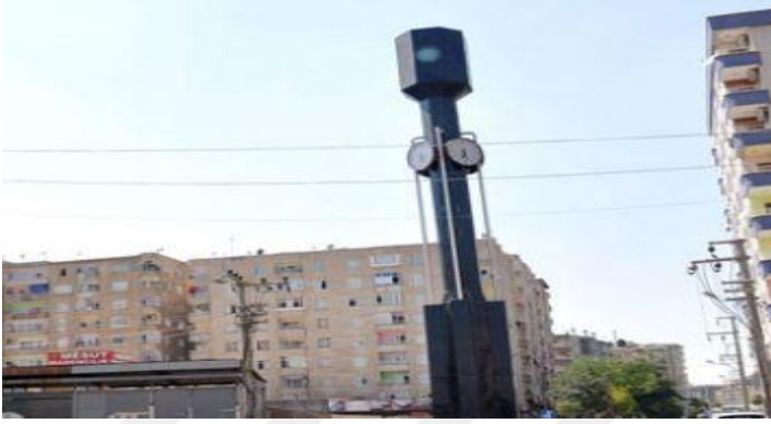
Şekil 12. Saat kulesi içerisine yerleştirilmiş baz istasyonu (URL-7)
