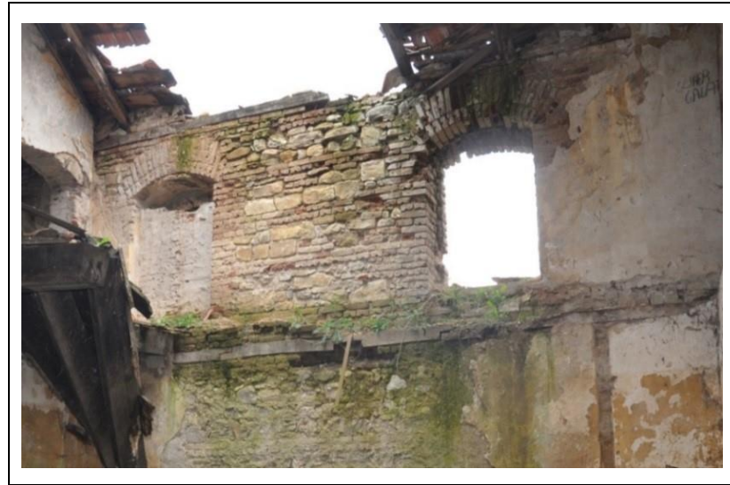
Şekil 4.19: 1-01 nolu mekânın doğu duvarı (2018)
