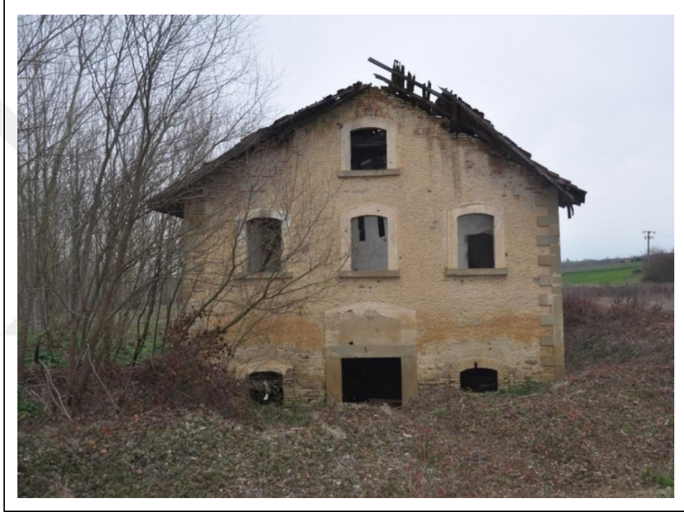
Şekil 4.22: Yapıya güneyden bakış (2018).
