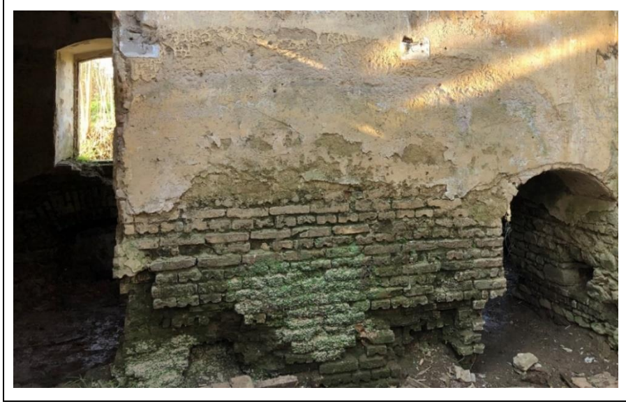
Şekil 4.33: Değirmenin iç duvarları.
