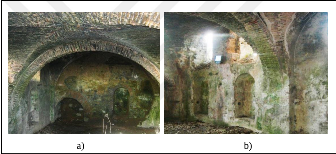
Şekil 2.9: a) Matbaanın tuğla örgülü çapraz tonoz çatısı (2018), b) Matbaanın beden duvarları (2018).
