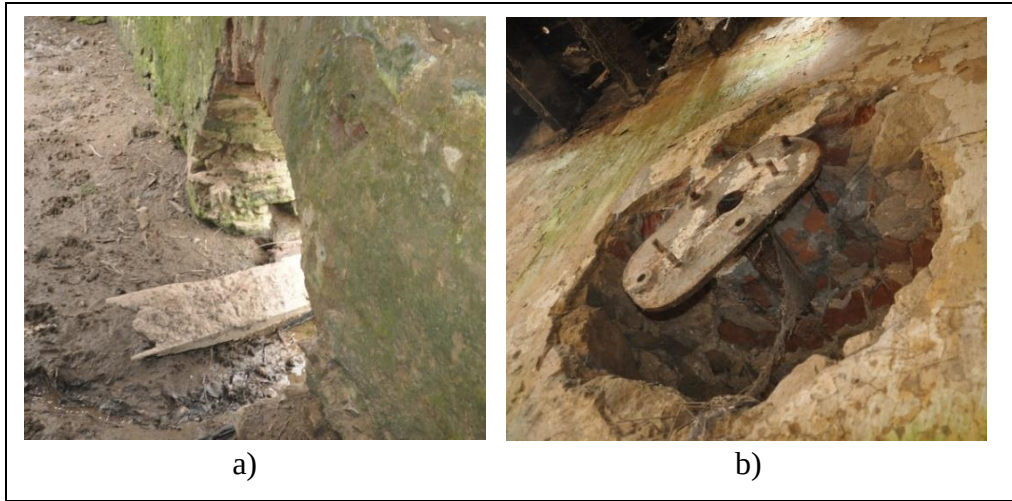
Şekil 4.8: a) Z-01 batı duvarındaki açıklık, b) Su çarkında kullanılan metal kol yuvası (2018).
