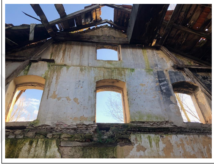
Şekil 4.16: 1-01 nolu mekânın güney duvarı (2018).
