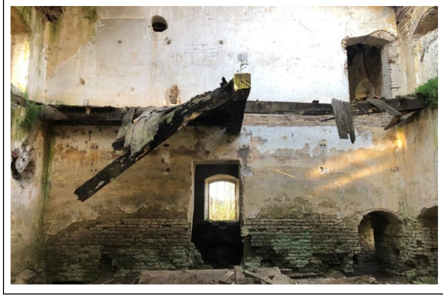
Şekil 4.10: Z-01 nolu mekânının kuzey duvarı (2018).
