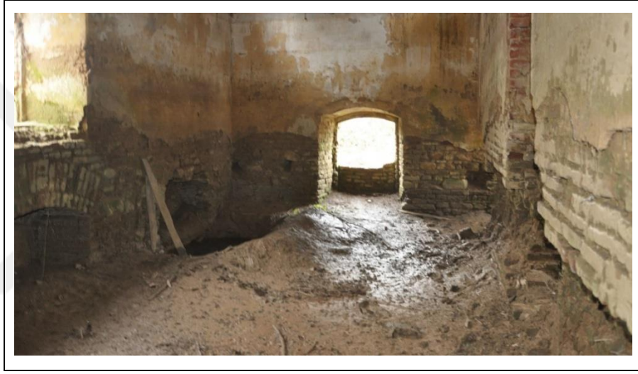
Şekil 4.39: Z-02 mekânının zemini.
