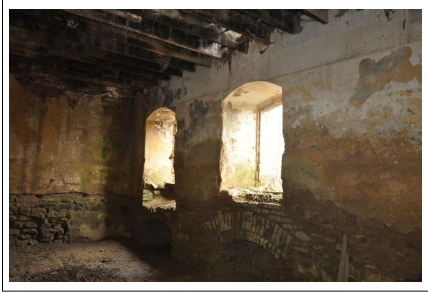
Şekil 4.13: Z-02 nolu mekânının kuzey duvarı (2018).
