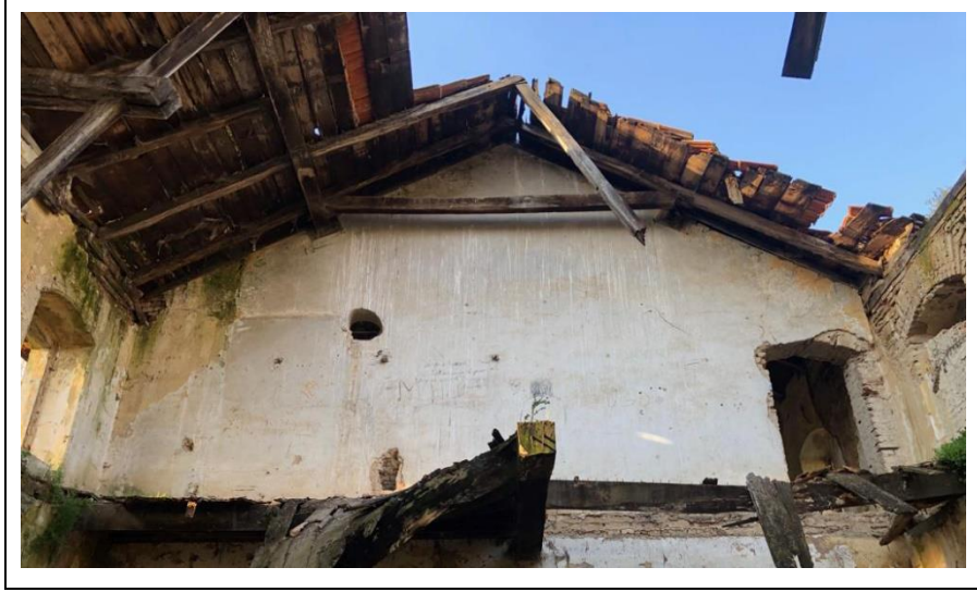
Şekil 4.20: 1-01 nolu mekânın kuzey duvarı.
