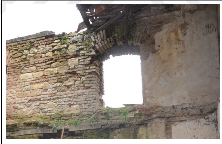
Şekil 4.32: Değirmenin doğu duvarında bulunan ahşap hatıllar.
