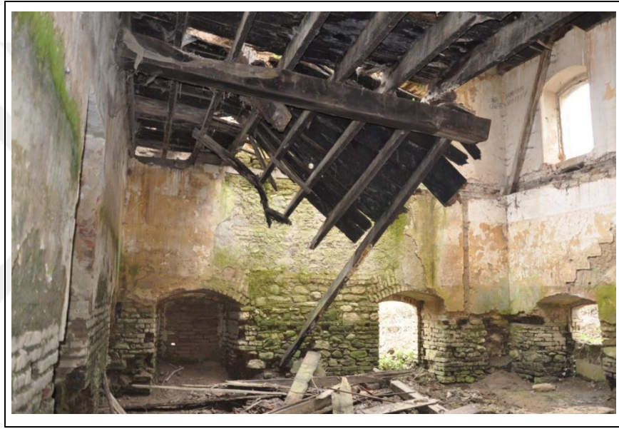
Şekil 4.9: Z-01 nolu mekânının doğu duvarı (2018).
