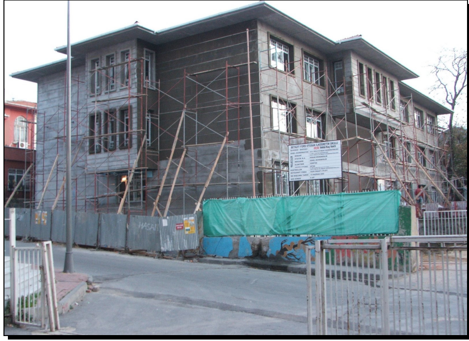
Resim 6. Koç Vakfı Tarafından Yapılan Yeni Okul Binası İnşaata (Kaynak: M. Küçükkoğlu arşivinden).
