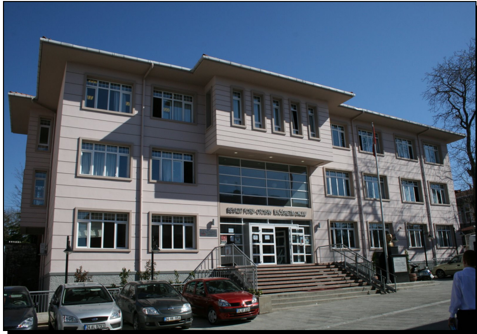
Resim 7. Koç Vakfı Tarafından Yapılmış Yeni Okul Binası (Kaynak: M. Küçükkoğlu arşivinden).
