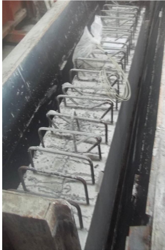
Şekil B.6 Kirişlerin beton dökümü
