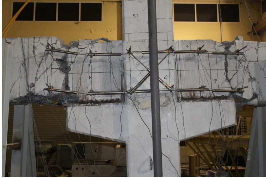
Şekil 4.15 N2 numunesinin % 5,0 ötelenme oranındaki hasar durumu
