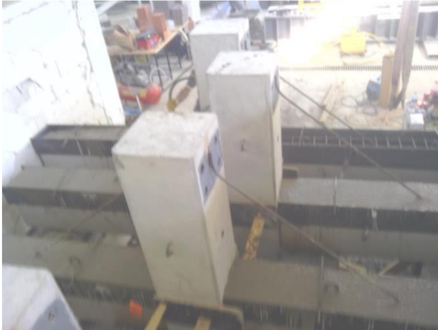
Şekil B.10 Tamamlayıcı beton dökümü
