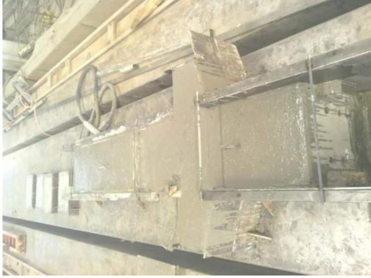
Şekil B.5 Kolonda beton dökümü
