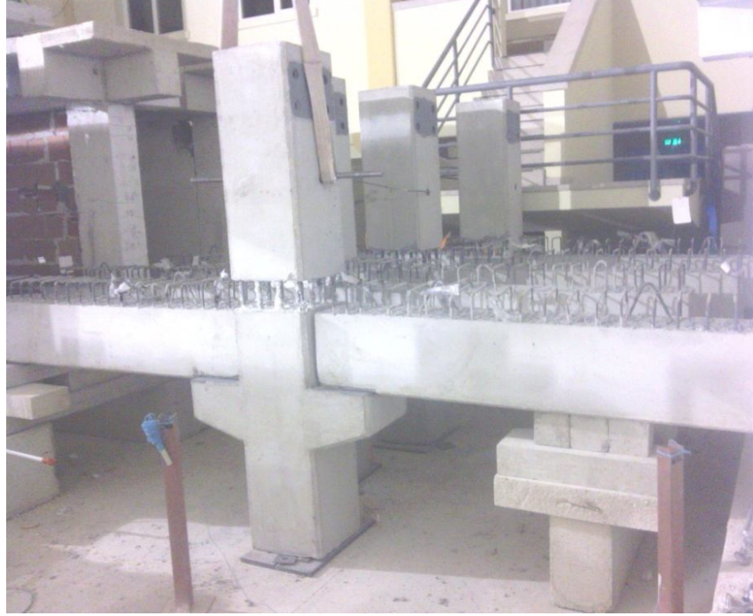
Şekil 3.4 Prefabrik birleşim bölgesi numunelerinin montajı
