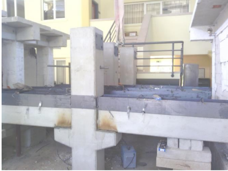
Şekil B.9 Kirişlere ve birleşime tamamlayıcı beton için kalıp hazırlığı
