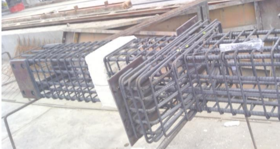
Şekil B.4 Kolonda birleşime gerinim pullarının yerleşimi
