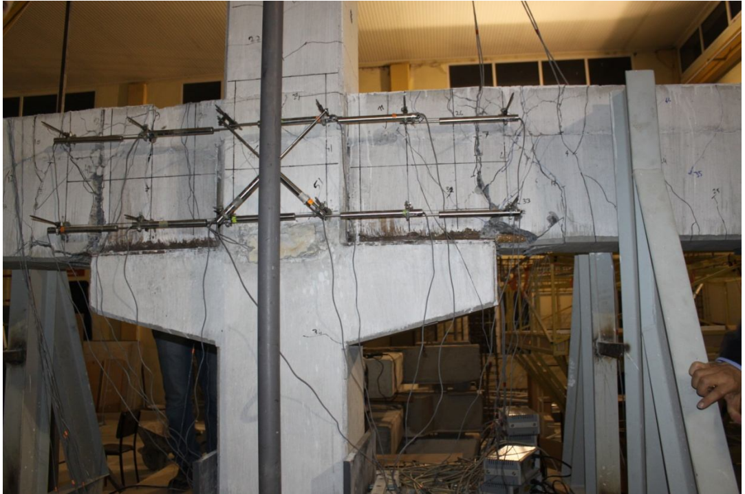
Şekil 4.14 N2 numunesinin % 2,75 ötelenme oranındaki hasar durumu
