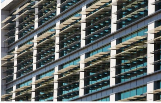
Şekil 4.6. Solda: Güney Cephede Gün Işığını Açık Ofislerin Derinliklerine Taşıyan ve Işık Rafları Vazifesi Gören Sabit Panjurlar (Aynı zamanda iç mekânı güneş ısısından da korumaktadırlar. Pencere içlerinde parlamayı önleyen otomasyonlu storlar bulunmaktadır.) Sağda: İç Mekândan Işık Raflarının Görünüşü
