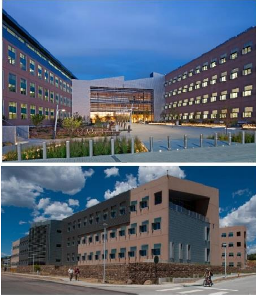
Şekil 4.11. Üstte: Doğuya Bakan Bina Giriş Avlusu, Altta: Güney Kanat ve Güneş Kolektörü
