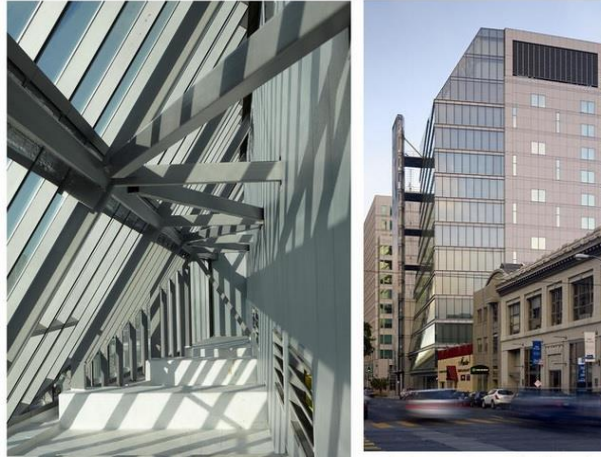
Şekil 4.2. Kuzeybatı Cephede Yan Arsadaki İlkokulun Oyun Alanına Gelen Güneşi Kesmemek Amacıyla Pahlanmış Üst Kat
