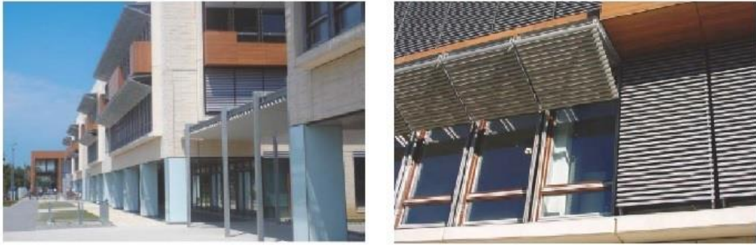
Şekil 3.7. Bina Otomasyon Sistemine Bağlı Yatay Hareketli Alüminyum Kepenk Sistemi (Campeon Ofis Binası, Münih, Almanya, Mimarlar: Maier Neuberger Projekte GmbH) [85]
