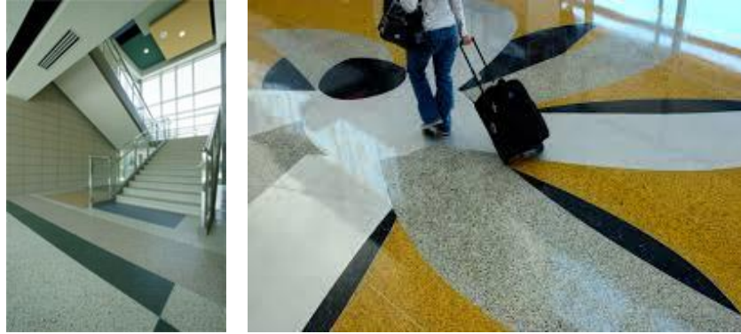
Şekil 3.27. Geri Dönüştürülmüş Camdan Üretilmiş Yüzey Kaplama Malzemesiyle Yaratıcı Uygulamalar 133
