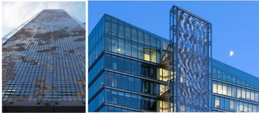
Şekil 4.3. Bina Cephesine Bir Sanatçının Katkısı (Rüzgâr tribünü kulesinin ön cephesine, Ned Kahn 159 tarafından yapılan “Ateşböcekleri” adındaki bir yerleştirme eseri monte edilmiştir. Mini paneller rüzgârın etkisiyle hareket etmekte ve güneş ışınlarına göre parlamaktadır.)
