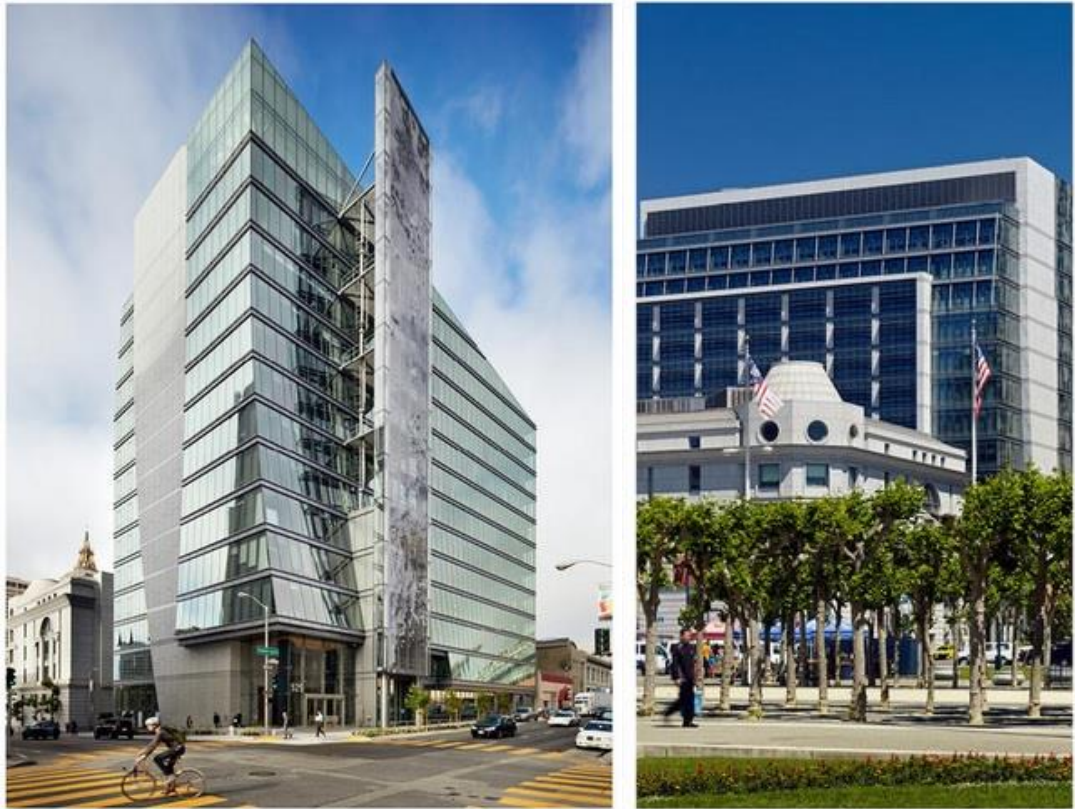
Şekil 4.1. Solda: Binanın Kuzeydoğu Köşesinden Görünüşü (Binanın formu, rüzgârı, cephe ile kule arasındaki platformlara yerleştirilmiş düşey tribünlere doğru yönlendirecek biçimde tasarlanmıştır.), Sağda: Binanın Güney Cephesinden Görünüşü
