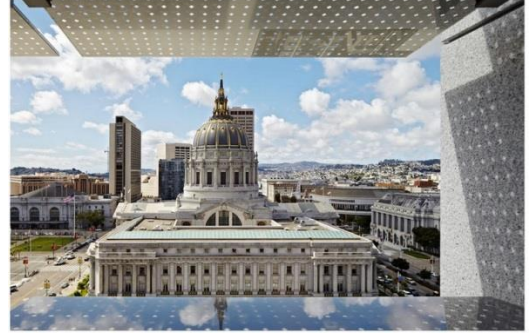
Şekil 4.6. Solda: Güney Cephede Gün Işığını Açık Ofislerin Derinliklerine Taşıyan ve Işık Rafları Vazifesi Gören Sabit Panjurlar (Aynı zamanda iç mekânı güneş ısısından da korumaktadırlar. Pencere içlerinde parlamayı önleyen otomasyonlu storlar bulunmaktadır.) Sağda: İç Mekândan Işık Raflarının Görünüşü
