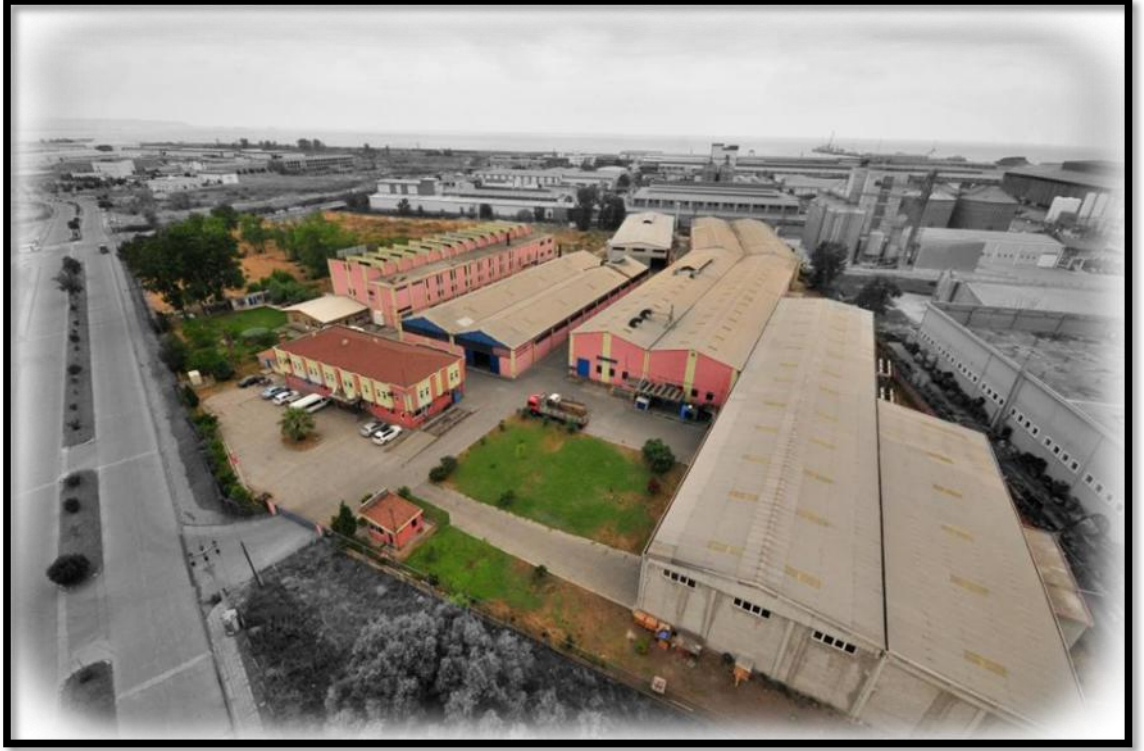
Şekil 3.1. Veri temini yapılan tesisin genel görünümü
